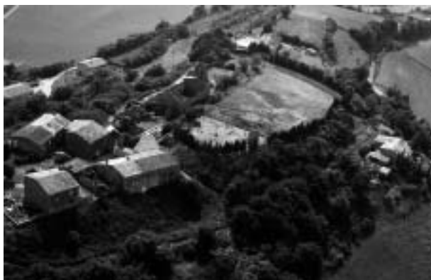
Figure 3 : Photo aérienne de la plate-forme du sommitale (M. Passelac, J.-P. Cazes)
