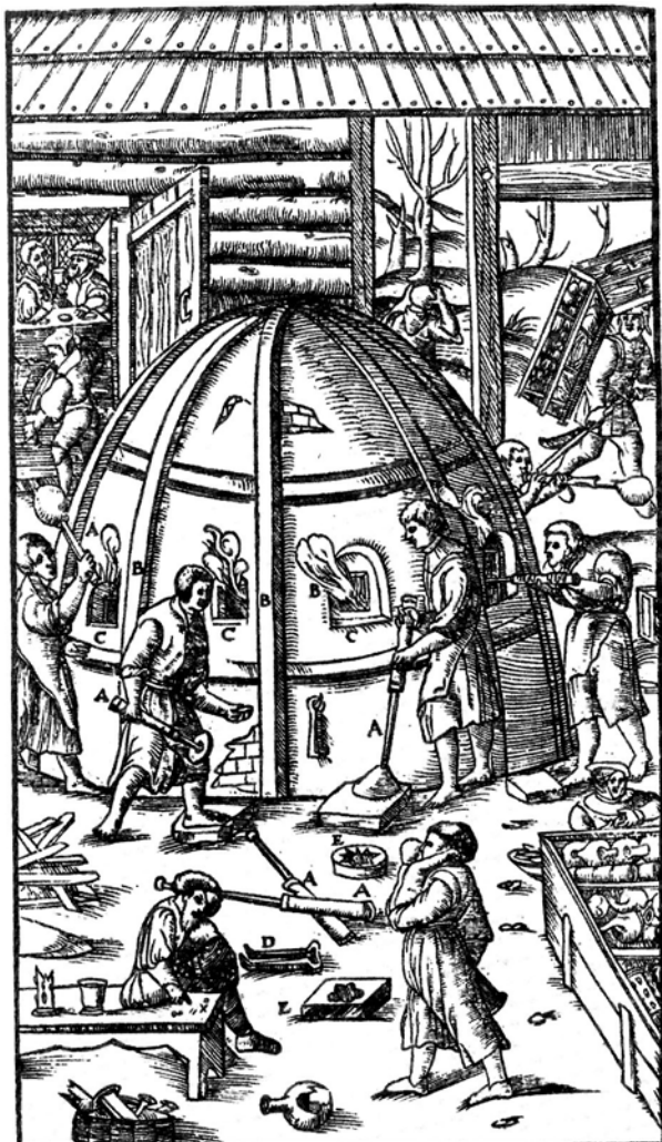
Figura 21. Representación de un horno de fusión bastante similar, en cuanto a tamaño y morfología, al de plaza Belluga.
