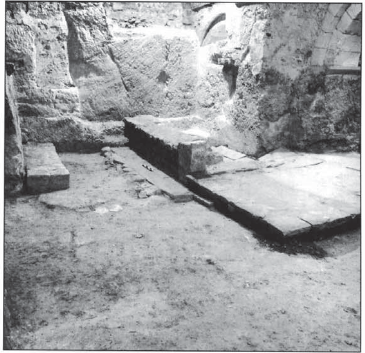
Fig. 7 – Au centre le mur d'échiffre sur le premier dallage, le second dallage ; à gauche le massif maçonné, souvenir de la sépulture (?), vue vers le nord.
