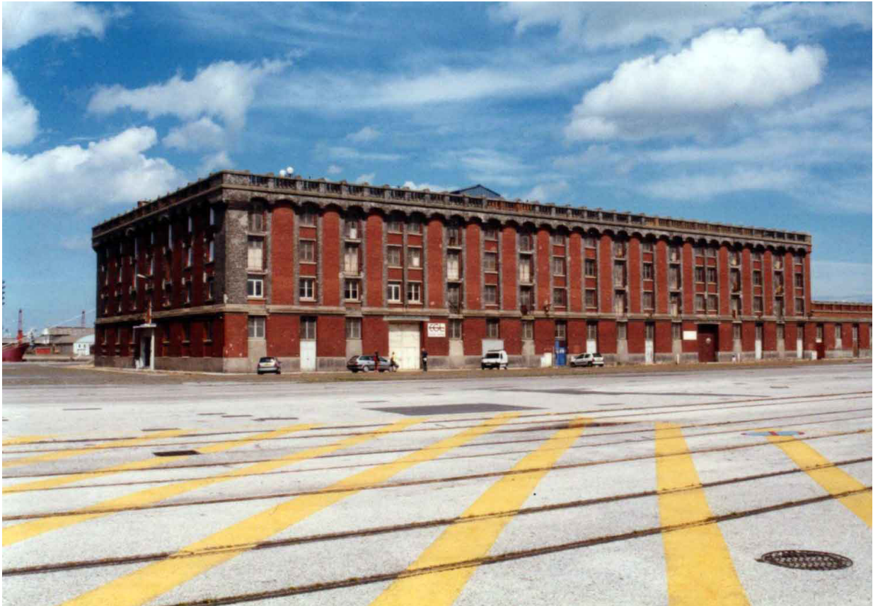
III. 29 : L'ancien entrepôt des sucres : futures Archives municipales de Dunkerque, Dunkerque (Nord), 2004. Photographie : Christian Hottin.
