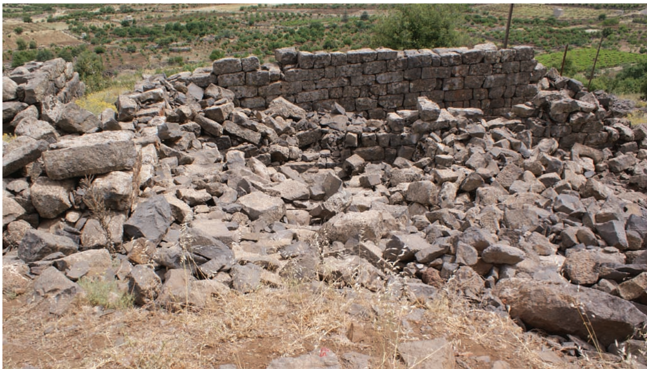
Fig. 5. Terrasse au nord-ouest de la cour 3: état au début de la mission 2010.
