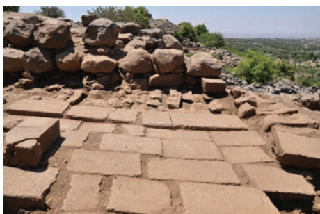
Fig. 19. Dallage et support de gradin légèrement surélevé conservés dans l'angle nord-ouest de la cour 3.
