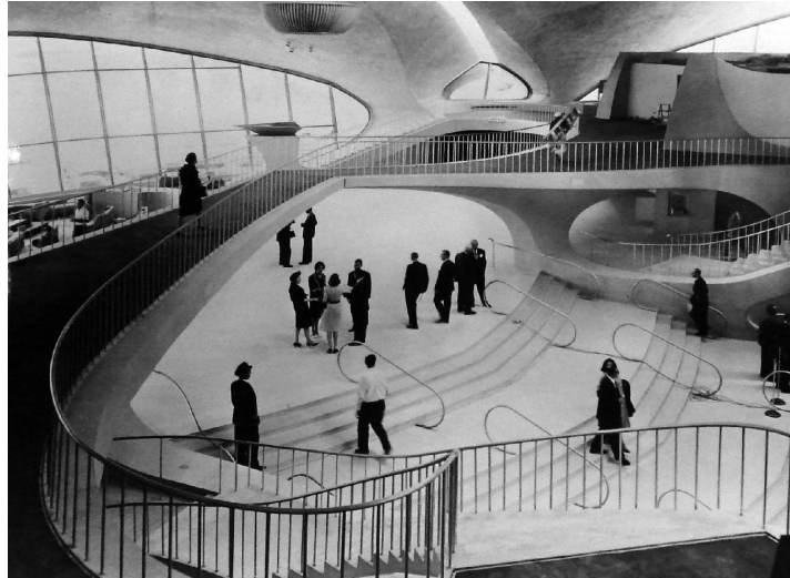
Vue intérieure du terminal TWA, 1962.
