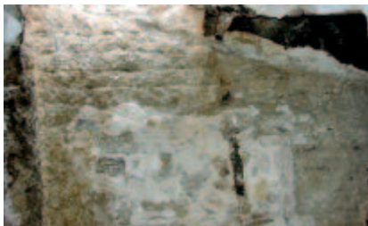
Figure 5. Bauge, lits de terre et rangs de brindilles. Béziers, France, XIV e s. (C.-A. de Chazelles).
