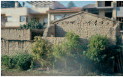
Figure 4. Adobe et brique cuite. Catalogne occidentale, Espagne (C.-A. de Chazelles).
