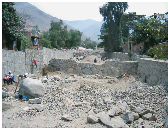
Figura 5 – Obra de acondicionamiento de la quebrada Quirio
