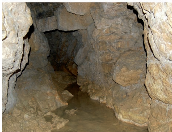
Fig. 8. Extrémité de la galerie de captage (85 m) dans l'éboulis, source des Dartreux. À la base : les marnes gorgées d'eau.
