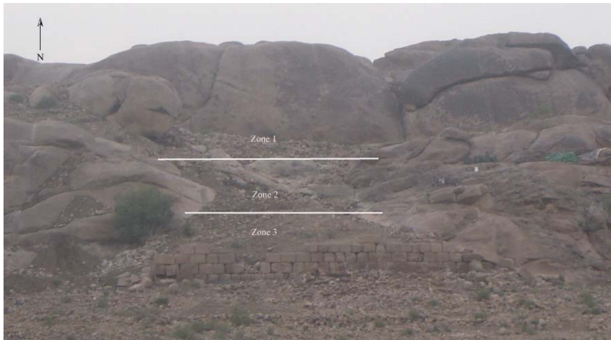
Figure 3 : vue de la rampe monumentale et limites des zones 1, 2 et 3
