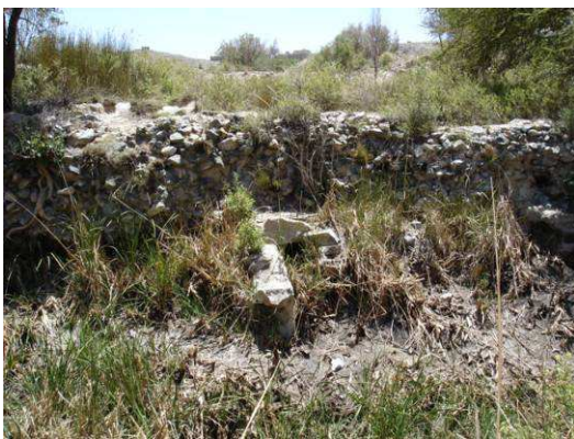
Figure 18 : barrage sur le wādī Shawkân
