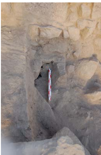
Fig. 41. Ḥaṣī, édifice à terrasses, secteur 3 Ouest, égout
