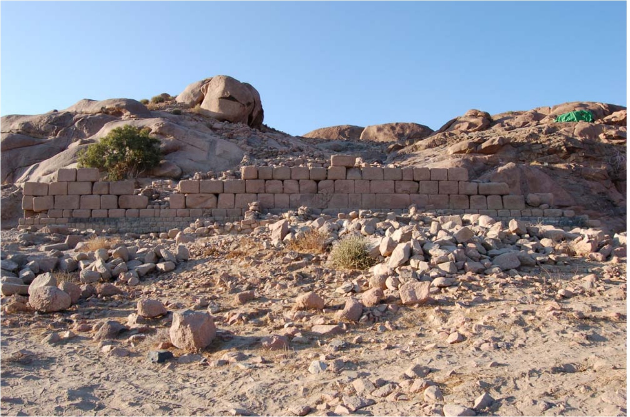
Fig. 43. Ḥaṣī, région A, façade méridionale de l'édifice à terrasses (mur MA 050)
