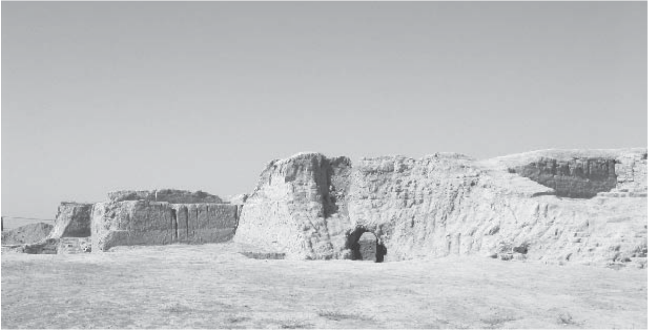
Fig. 31 - Temple. Les seuls vestiges de façade du 3ème état et le tunnel. Vue vers l'ouest.
