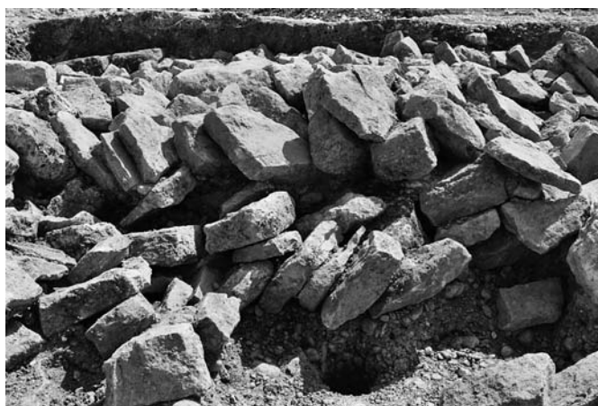
Fig. 32 – Vue du nord-ouest du détail des deux niveaux de hérisson conservés dans la fondation du mur d'enceinte de Mandeuve à l'ouest de la tour 1 (cliché : G. Kuhnle, INRAP).
