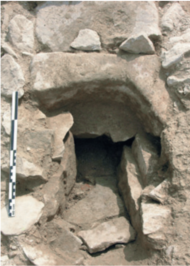
ill. 24. Détail de l'entrée des eaux à l'extrémité nord de la canalisation H. (R. Pellé, Inrap)
