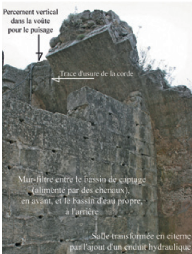
ill. 18. Exemple de fonctionnement d'une citerne médiévale : la citerne du château des Baux-de-Provence. (Bouches-du-Rhône). (O. Mauftras, Inrap)
