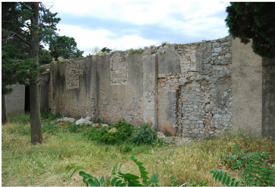
Fig. 1 - Saint-Pierre d'Ilovik, sondages dans les enduits du mur sud : découvertes des baies (cl. S. Bully).
