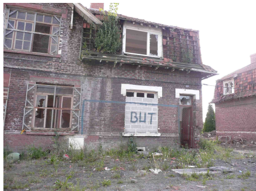
Cité minière en cours de réhabilitation à Wingles (photo Bénédicte Lefebvre)
