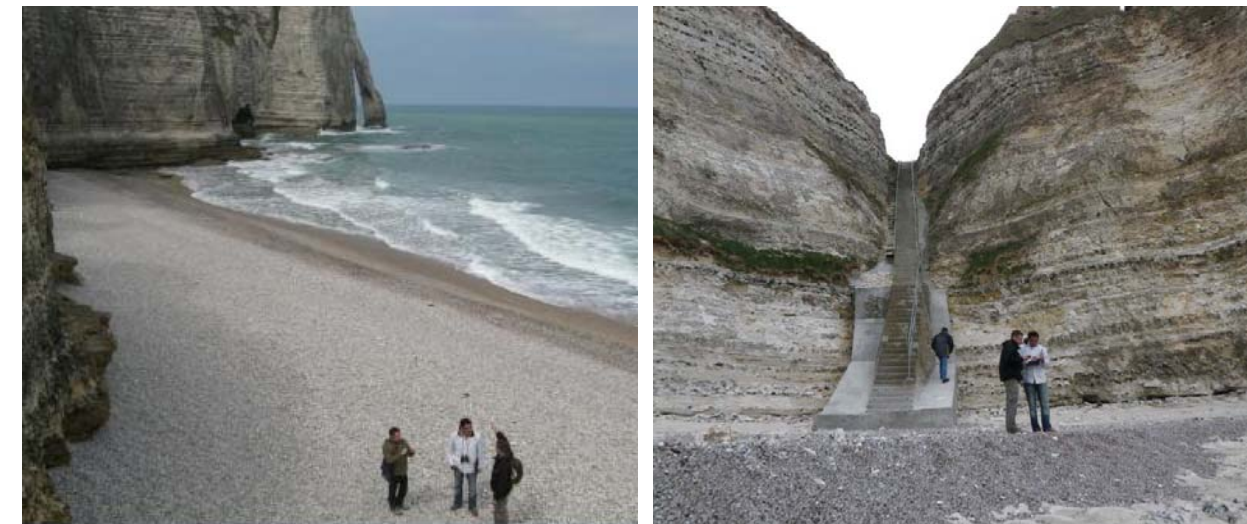
Photographies 1 et 2 : relevé des ouvrages côtiers à Etretat et à Eiletot
