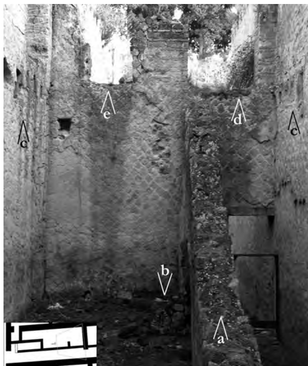
Fig. 139 – Insula Orientalis II a , pièce 7-3, mur est. a: mur de refend intégralement reconstruit lors de la fouille, sans respecter toutes les maçonneries visibles; b: montant oriental d'un passage entre le couloir 7-1 et la pièce 7-3, partiellement restauré; c: solives encadrées de tuiles supportant l'étage partiel dès la première phase; d: porte donnant accès à l'étage surplombant les pièces 7-4 et 7-5, incluse dans la construction originelle; e: porte percée sans soin lors de la dernière phase.
