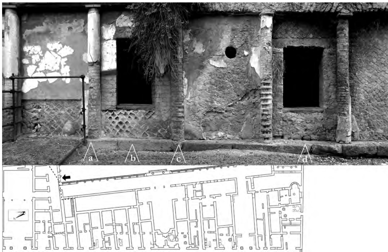
Fig. 121 – Partie ouest du cryptoportique donnant sur de la terrasse inférieure de l' Insula Orientalis II a . Les variations dans les maçonneries ne caractérisent pas des changements de phase mais l'emploi progressif de techniques différentes de mise en œuvre. D'abord construites en opus vittatum (a), les colonnes s'appuient sur un massif en opus reticulatum B continu à la base des fenêtres (b). Elles sont ensuite construites en opus vittatum mixtum à une assise de briques (c), alors que la base des fenêtres n'est plus construite de façon continue, mais dans un second temps du chantier (d).
