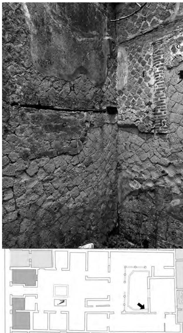
Fig. 177 – Casa del bicentenario (V, 13-16), jardin, angle sud-ouest. Les colonnes (b) supportant un mur en opus reticulatum B (a) correspondent au premier aspect du péristyle. Après le séisme de 62, l'entrecolonnement est bouché sur tout le côté occidental (c) et la pièce 10 créée au sud (d). On y accède par plusieurs portes (e). Les réparations suivant le second séisme sont effectuées en employant l' opus reticulatum A (f). Les portes entre le jardin et la pièce 10 sont alors bouchées (g).
