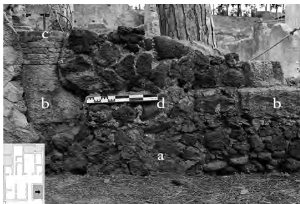
Fig. 163 – Casa del gran portale (V, 33-34), boutique V, 33, mur est. Vestiges du stylobate correspondant au péristyle associé à la Casa sannitica (V, 1) avant la période augustéenne. Sur celui-ci, construit en opus incertum B (a), deux bases de colonnes en tuf rossiccio ont subsisté (b). Celle située au nord présente un fût reconstruit avec des briques (c). Après le démantèlement du péristyle, des moellons sont employés pour édifier le mur périmétrique de la boutique (d).
