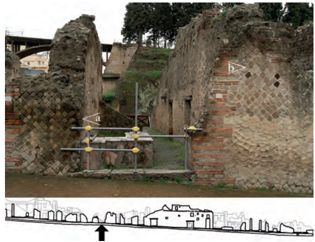
Fig. 131 – Façade du local Or. II, 13. Le montant gauche de la première phase a été remplacé par une paroi en opus reticulatum A lors des travaux effectués par Vespasien (a), comme la comparaison avec la maçonnerie originelle (b) permet de le constater. L'absence de moellons isodomes dans le montant nord révèle que l'entrée était beaucoup plus réduite tant lors du projet initial qu'après les travaux terminés en 76. L'ouverture de cette boutique ne serait alors qu'un bricolage précédant de peu l'éruption.
