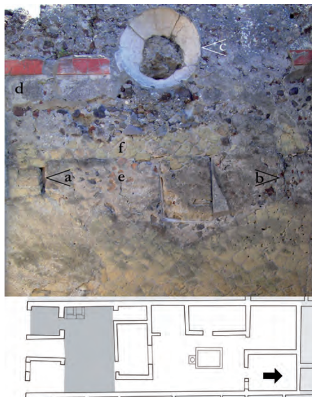
Fig. 160 – Casa della fullonica (IV, 5-7), pièce 7, mur est. Cette paroi, s'ouvre sur la pièce 5 de la Casa del priapo (IV, 17-18), grâce à une porte dont on perçoit les montants (a-b) et l'empreinte du linteau (f), et à un oculus (c). Des fragments de décoration de 1 er style (d) sont conservés. Après le second séisme, le montant sud (b) a été réparé en employant la technique du coffrage, puis dans un second temps, la porte a été murée (e).
