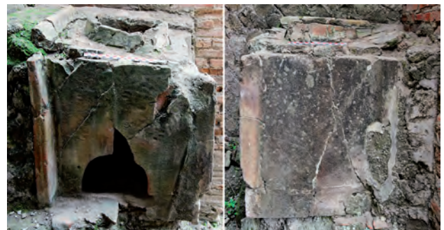
Fig. 37 – Aménagement pour la cuisson construit avec des tuiles dans le local DM 8E (vue des faces septentrionale et occidentale).
