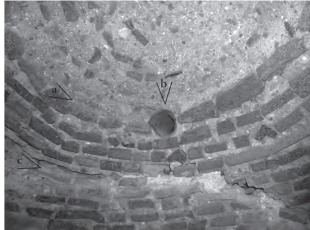
Fig. 74 – Intérieur du four de la boulangerie Or. II, 8 à Herculanium. Le sommet de la coupole, au lieu de bénéficier d'un parement de tuiles, a été réalisé en jetant du béton sur une forme circulaire. La limite (a) entre les deux formes de maçonnerie est très nette. Une amphore (b) a été insérée pour ménager un conduit d'aération. Une ligne de fracture (c), correspondant à l'effondrement de la partie antérieure du four, est également visible (cliché pris du sud/sud-est).
