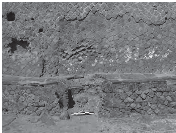
Fig. 80 – Table maçonnée dans l'atelier Or. II, 18 à Herculaneum. En dépit des importantes restaurations qui ont touché cette table, la structure de la chaudière « basse » au centre permet d'identifier cet atelier comme une officine de nettoyage des toisons (cliché pris du sud).
