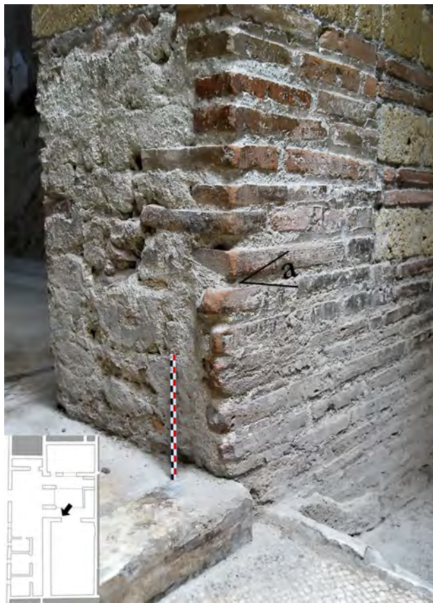
Fig. 181 – Casa del bel cortile (V, 8), pièce 4, montant ouest. Cette portion du montant montre une phase de construction en opus testaceum (limite supérieure en a), remontant au séisme de 62. Dans un second temps, le reste du montant a été reconstruit en opus vittatum mixtum à deux assises de briques.
