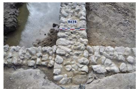
Fig. 7 : Détail de la mise en œuvre de l'arase au niveau de l'intersection des murs MR27444 et MR27543 à MR27545 (vue du nord-ouest).
