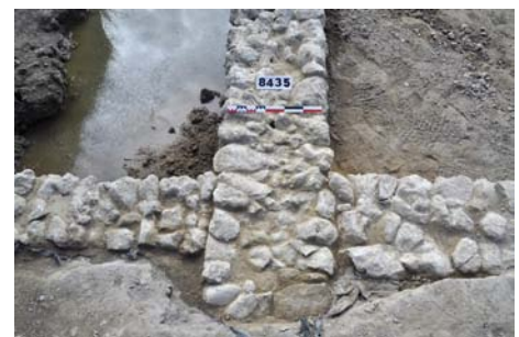
Fig. 7 : Détail de la mise en œuvre de l'arase au niveau de l'intersection des murs MR27444 et MR27543 à MR27545 (vue du nord-ouest).
