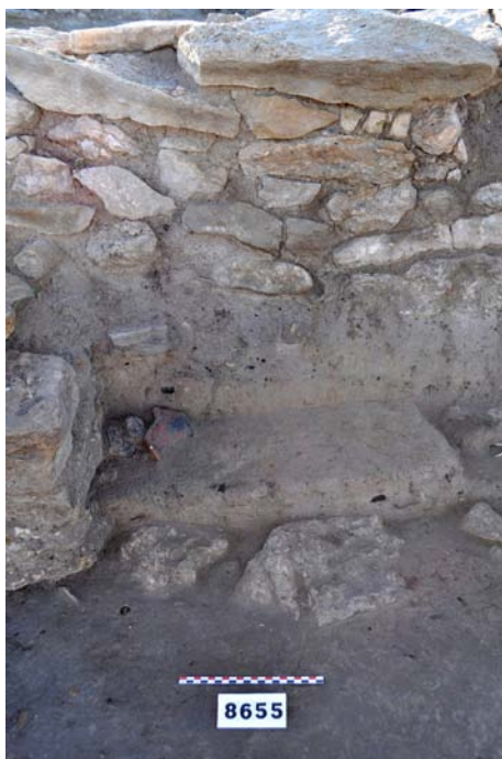
■ Fig. 41 : Détail du seuil de porte PR55061 fait d'adobes, dans le mur oriental de la pièce 8: prise de l'Ouest.
