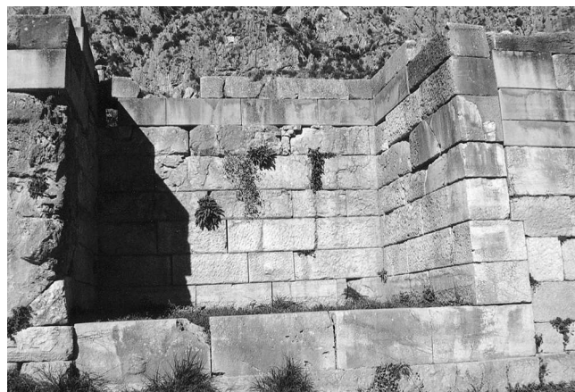
Fig. 5 – Sanctuaire d'Apollon à Delphes : niche quadrangulaire SD n°115 ; largeur : 3,94 m ; profondeur : 2,75 m ; hauteur cons. : 3,94 m – IV e s. (S. Montel).
