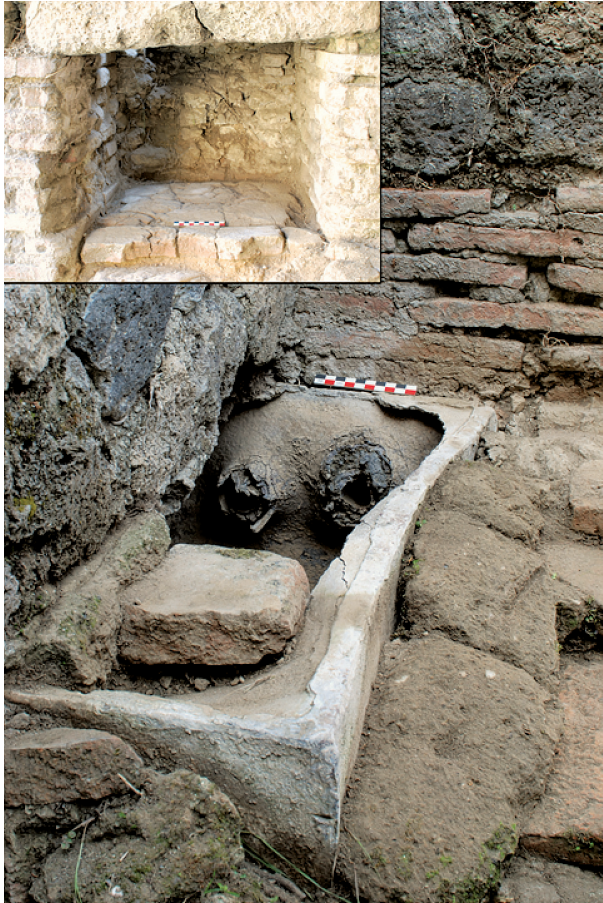
Fig. 71 - Pompéi, Pistrina . Chauffe-eau en plomb inclus dans le four de la boulangerie VII 12, 11. La face supérieure ayant disparu, on voit les tuyaux de remplissage et de vidange dans la paroi. En encadré, chambre de chauffe du même aménagement, vu de l'autre côté (clichés N. Monteix).
