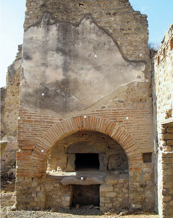
Fig. 74 – Pompéi, Pistrina . Vue générale du four en V 4, 01-02. En avant de la gueule du four et de l'autel se trouve le mur diaphragme, avec son arc caractéristique. Notez les changements d'appareil entre les zones inférieure et supérieure de la paroi (cliché A. Coutelas).
