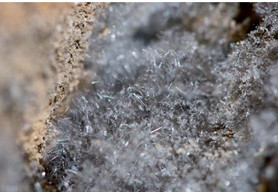
Photographie 2: vue de détail des cristallisations fibreuses de sulfates couvrant les parois de la seconde salle. Les cristaux mesurent environ 5 mm. Cliché K. Questel.
