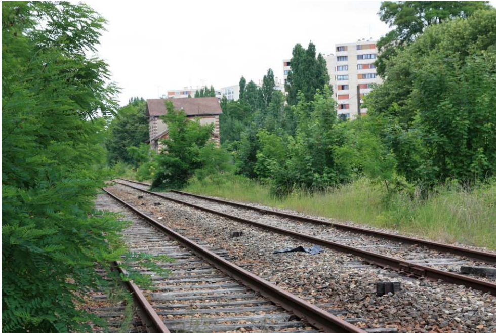
Figure 2 : Grande Ceinture, Voie ferrée désaffectée entourant la proche banlieue parisienne. Gare de Poissy (78)
