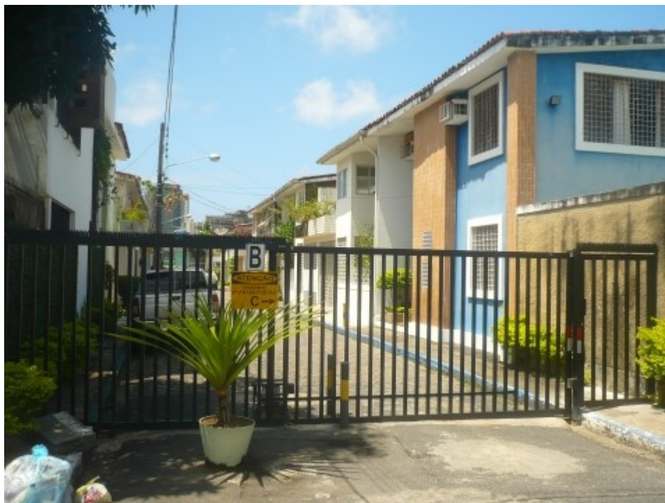
Figure 3 : Une des cinq entrées du Conjunto Residencial Casa Forte à Recife
