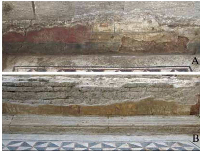
Fig. 11. Les peintures en place sur les parois ouest (A) et nord (B) de la pièce 7 (O. Vauxion).
