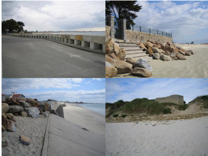
Digues et enrochements
