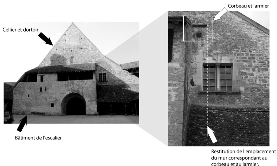
Illustration 4 – Façade nord du cellier et de la montée d'escalier. Mise en évidence des éléments antérieurs à la montée d'escalier. Photos M. Foucher
