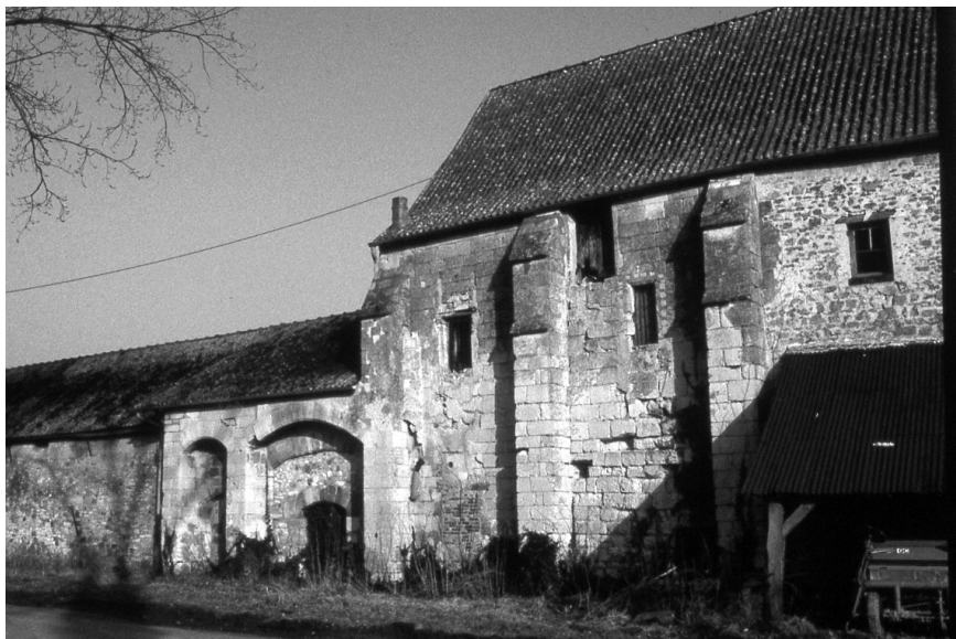
Fig. 16 b : grange de Fourcheret. Vue extérieure de la porterie avec des mâchicoulis sur arc (cl. Fr.B.)
