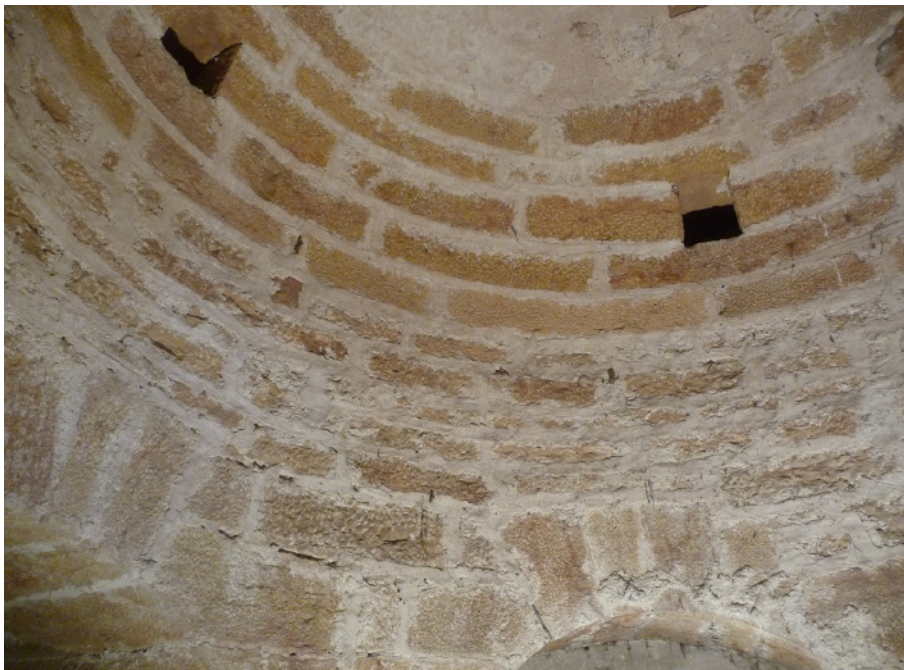
Fig. 10 : premier niveau, crochet de suspension d'une poulie, perforé de deux trous recevant l'axe de celle-ci. (Cl. R.P.L.)
