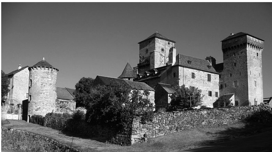
Fig. 25 : grange-château de Galinières. Vue actuelle (cl. Fr.B.)
