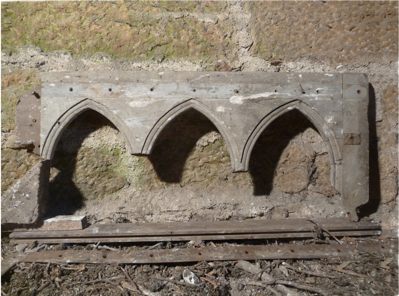
Fig. 15 : deuxième niveau, traverse haute du vantail de la porte ouest. (Cl. R.P.L.)
