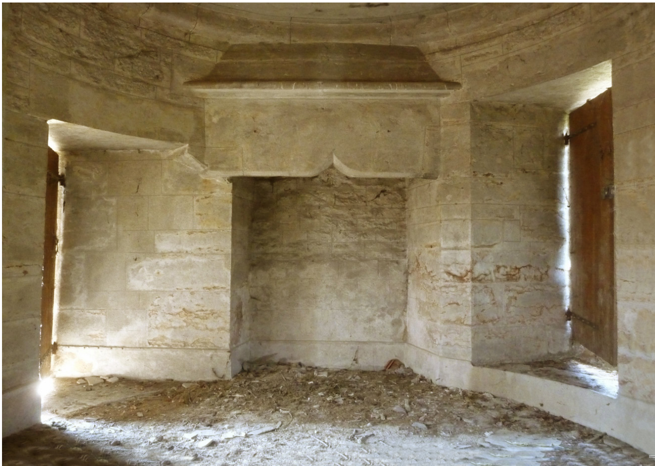
Fig. 14 : deuxième niveau, accolade taillée ultérieurement sur le linteau de la cheminée. (Cl. R.P.L.)
