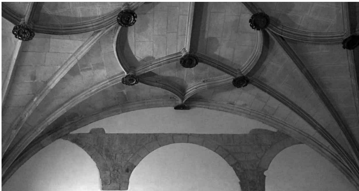
Fig. 10 : monastère de Santa Cruz : traces des arcatures romanes de la tour-porche (cl. José Augusto Leitão).
