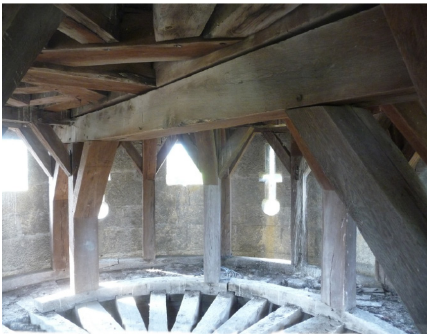
Fig. 19 : quatrième niveau, couronnement. (Cl. R.P.L.)
