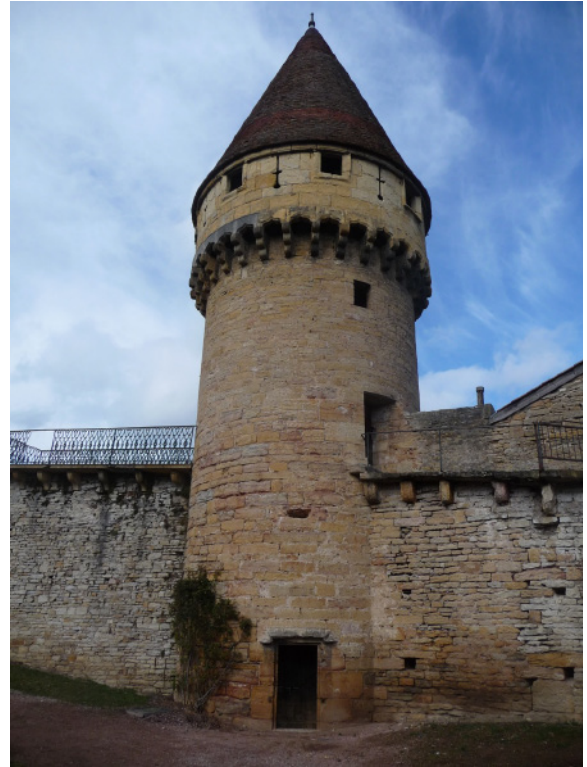
Fig. 4 : la tour Fabri vue du sud, à l'intérieur de l'enceinte. (Cl. R.P.L.)
