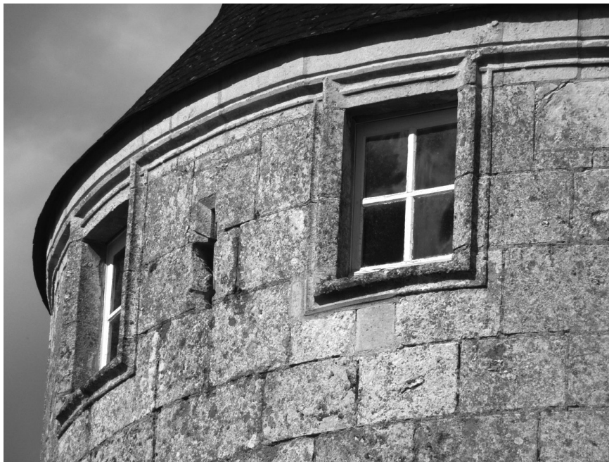
Fig. 23 : château de Frazé, châtelet, baies-créniaux à encadrement saillant dont la corniche de toiture forme le couverture de l'ouverture. (Cl. R.P.L.)
