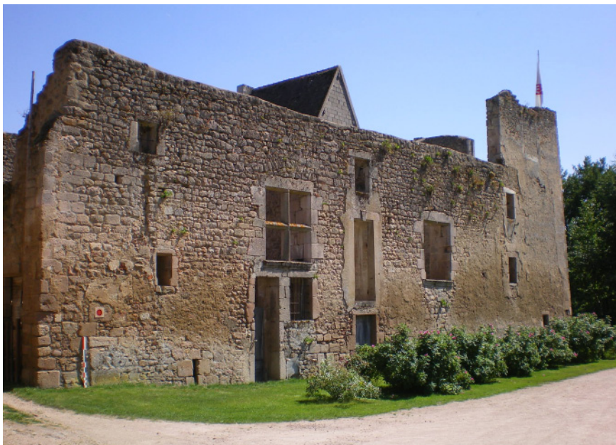
Fig. 3 : ancien prieuré de Mesvres, vue générale du bâtiment occidental (cl. Les amis du prieuré).
