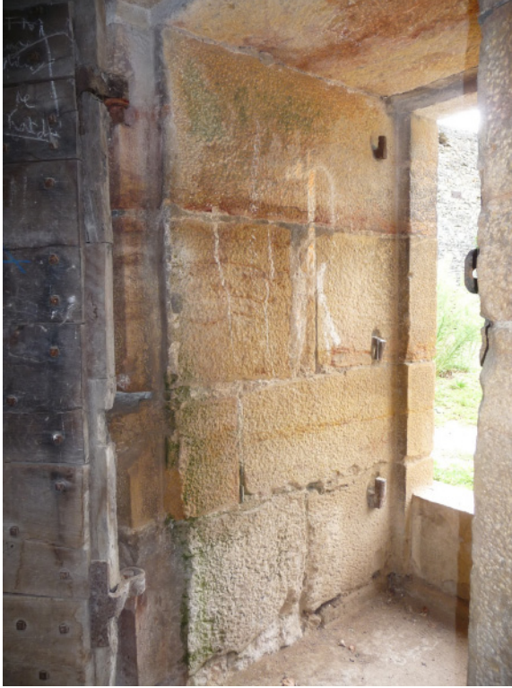
Fig. 6 : premier niveau, la porte vue de l'intérieur. Le bloc formant embrasure sous le couverture est un parpaing, tout comme celui qui accueille les gâches, sur le côté opposé de l'embrasure. (Cl. R.P.L.)
