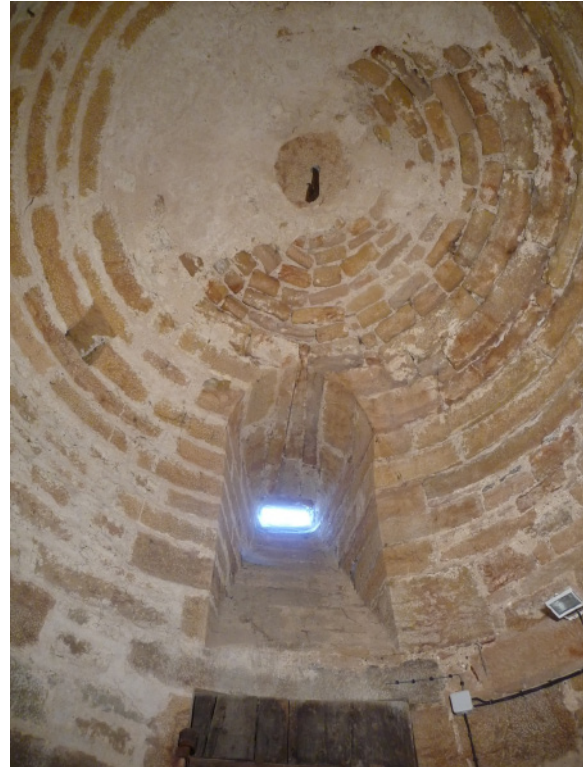
Fig. 11 : premier niveau, différents traitements de surface conservés ; sur la gauche : joints beurrés et enduit. (Cl. R.P.L.)
