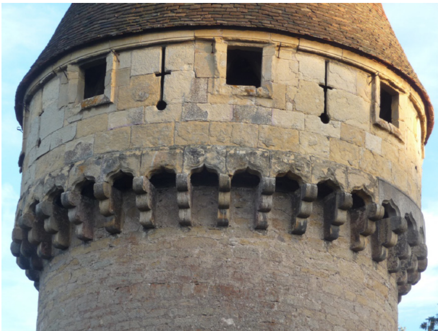
Fig. 5 : le couronnement, vu du nord-ouest. (Cl. R.P.L.)
