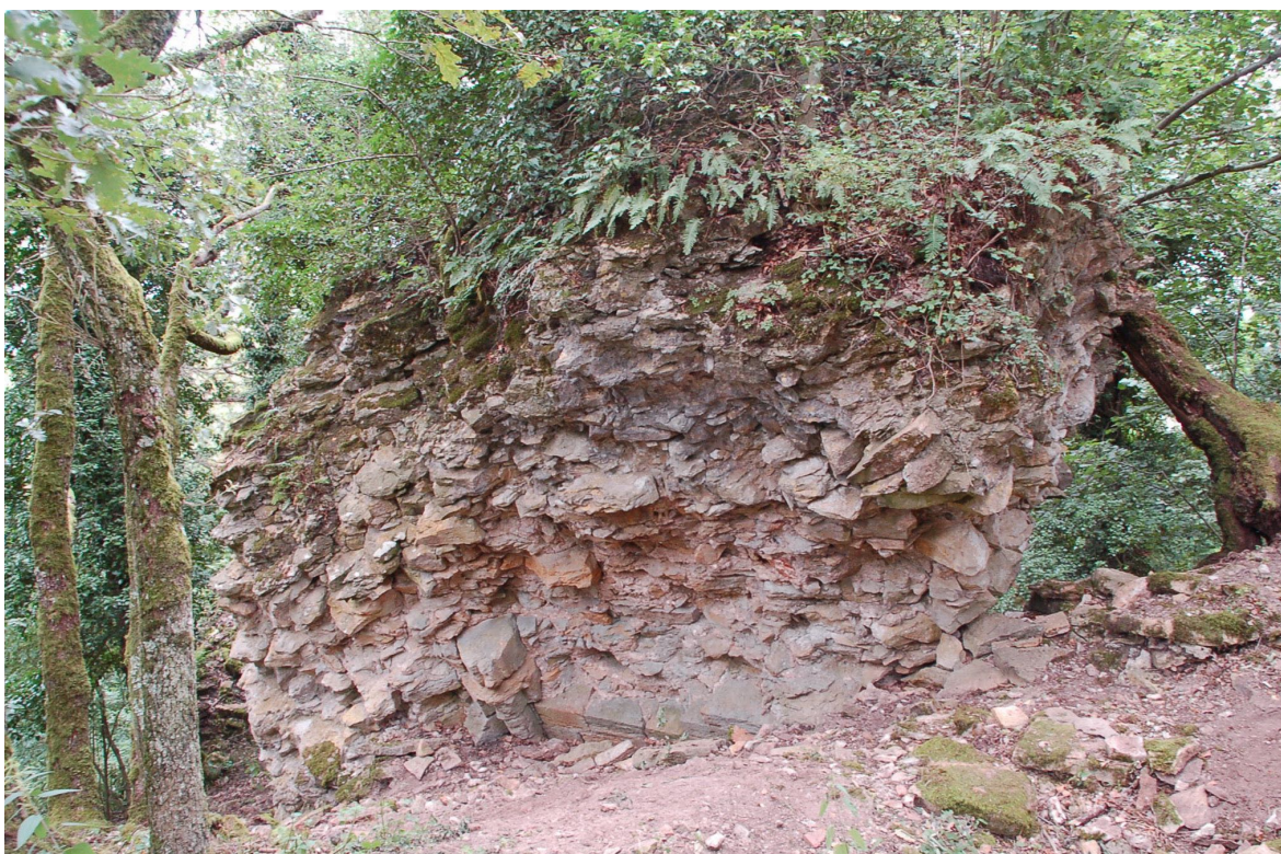
Fig. 16 et 17 : blocs erratiques de la tour ronde. En haut : parement extérieur et embrasure. En bas : parement intérieur et colonnette d'angle (cl. D. Rondot-Mandrou).
