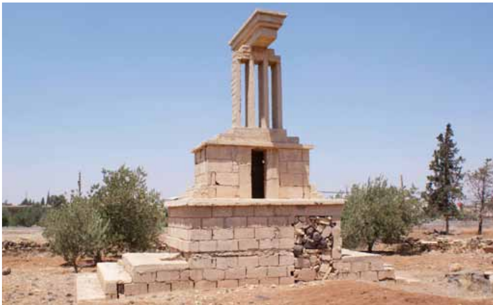
fig. 16. Le monument aux ruines antiques , al-Mutneh (cliché P. Piraud-Fournet 2009)
