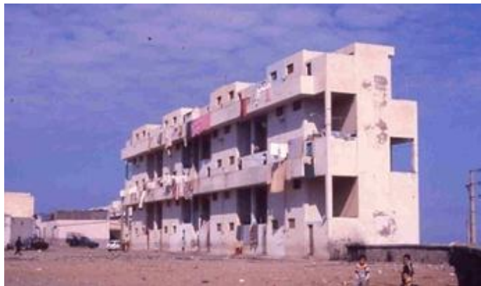
Fig. 3 : Les logements en duplex de l'ATBAT (Mostaganem, D. Pinson, 1976)
