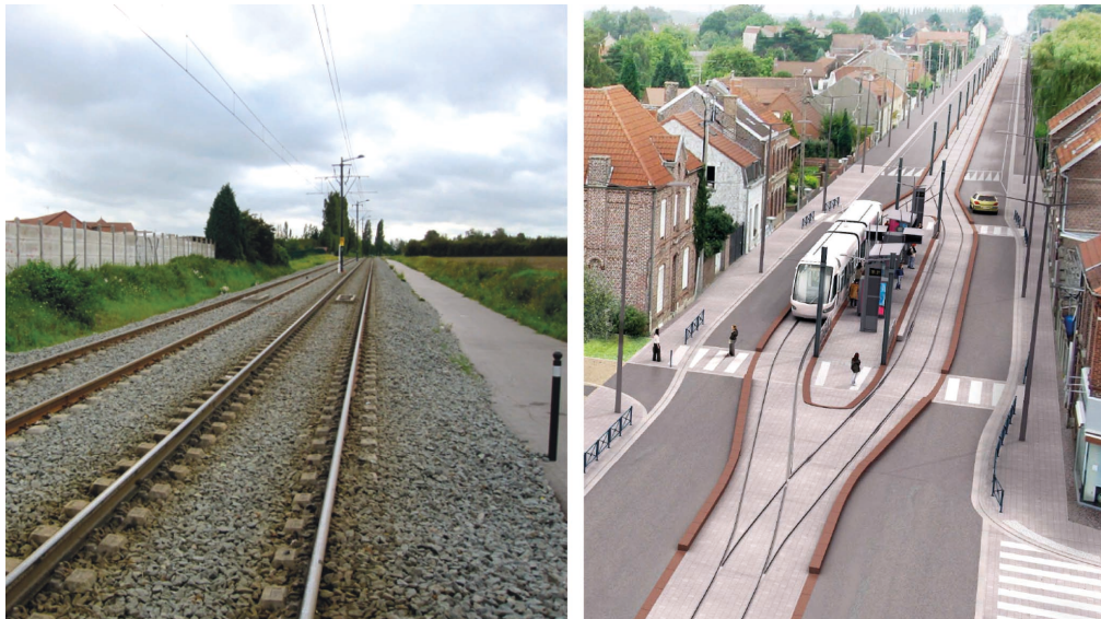
Figure 8 : Extension « low cost » des lignes de tramway dans le Valenciennois : voie en ballast vers Denain (à gauche, CETE Nord-Picardie), section à voie unique vers Condé (à droite, projet SITURV)
