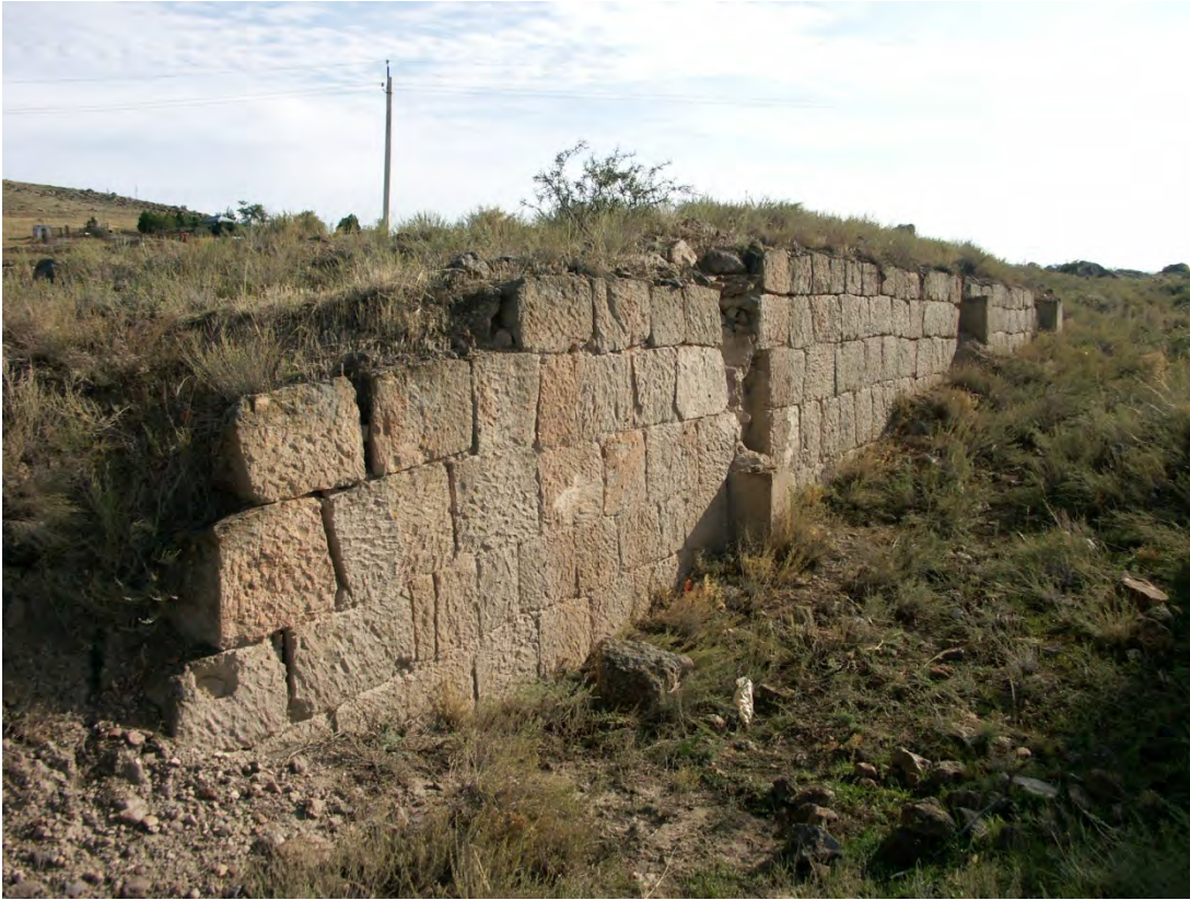
Fig. 18 : « Barrage ». Mur sud, face vers l'aval. Cliché de P. Donabédian, LA3M, 2010.
