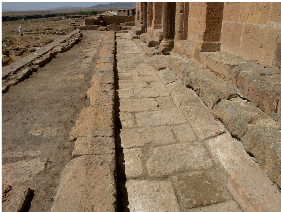
Fig. 138 : Galerie sud, vue vers l'ouest. Cliché de P. Donabédian, LA3M, 2012.
