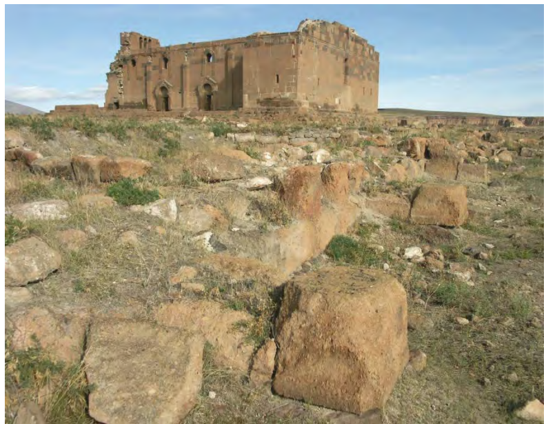
Fig. 14 : Mur d'enceinte à l'est de la basilique. Vue du sud-est. Cliché de P. Donabédian, LA3M, 2010.
