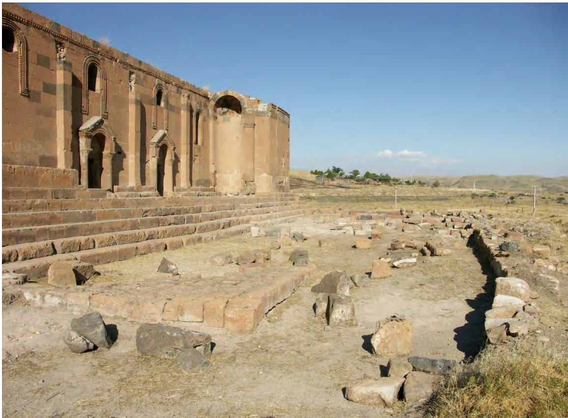
Fig. 11 : Flanc sud de la basilique. Zone mémoriale-funéraire. Cliché de P. Donabédian, LA3M, 2012.
