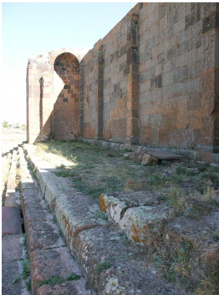
Fig. 140 : Basilique. Galerie nord, vue vers l'est. Cliché de P. Donabédian, LA3M, 2012.
