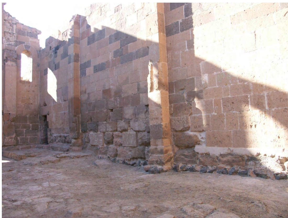
Fig. 137 : Basilique. Mur intérieur nord. Vue vers le NO. Cliché de P.Donabédian, LA3M, 2011.
