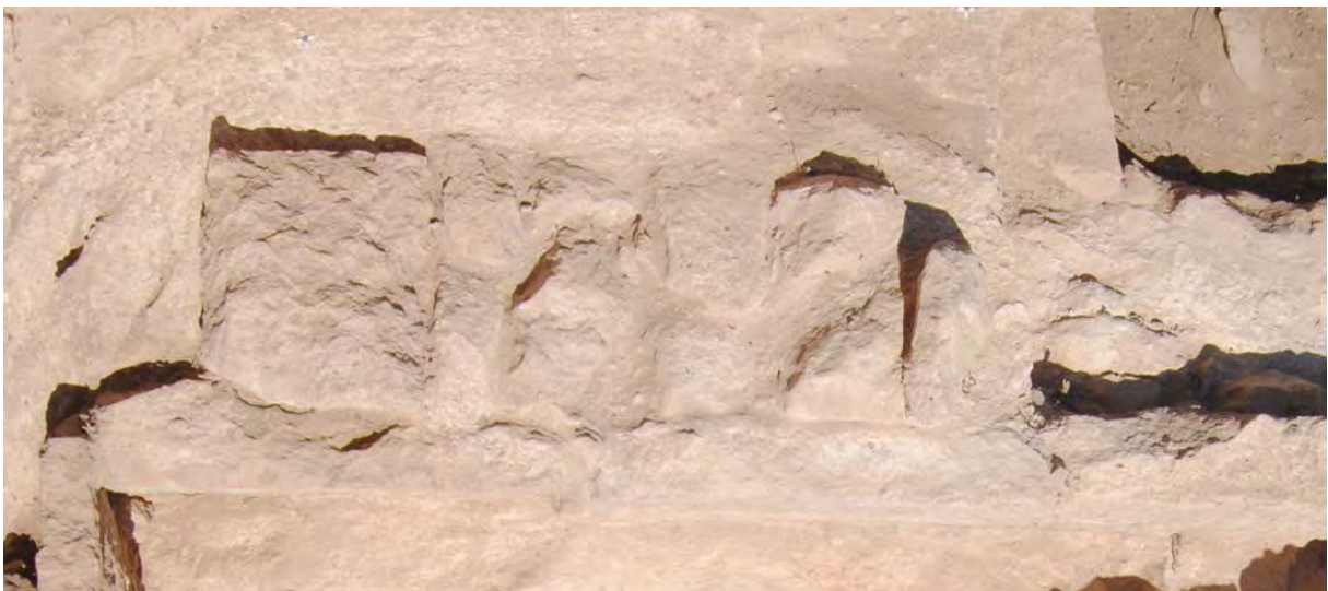
Fig. 94 : Vue nord du coffrage de la sépulture SEP 71. Cliché de G. Marchand, LA3M, 2012.
