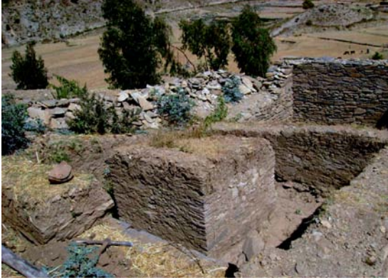
Fig. 20 – The stonework made-up pillar in 2008 (H. Mekonnen 2008 ©)
