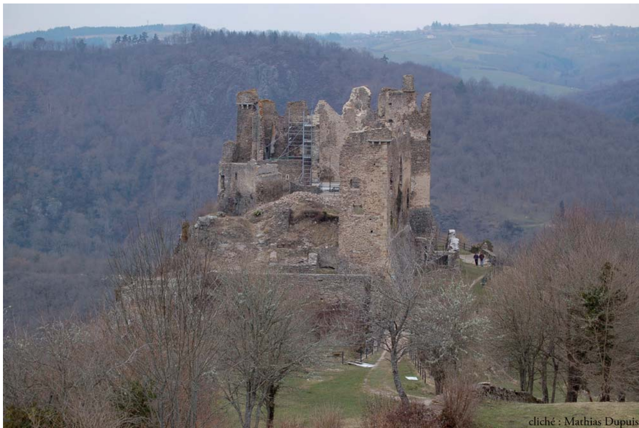
Fig. 3 : Vue du château depuis le sud-est (Mathias Dupuis).
