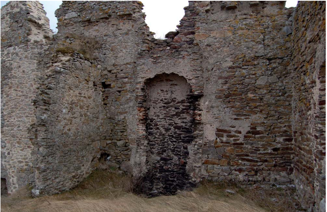
Fig. 10 : Vue de l'étage supérieur de la pièce 14 depuis le nord (Mathias Dupuis).
