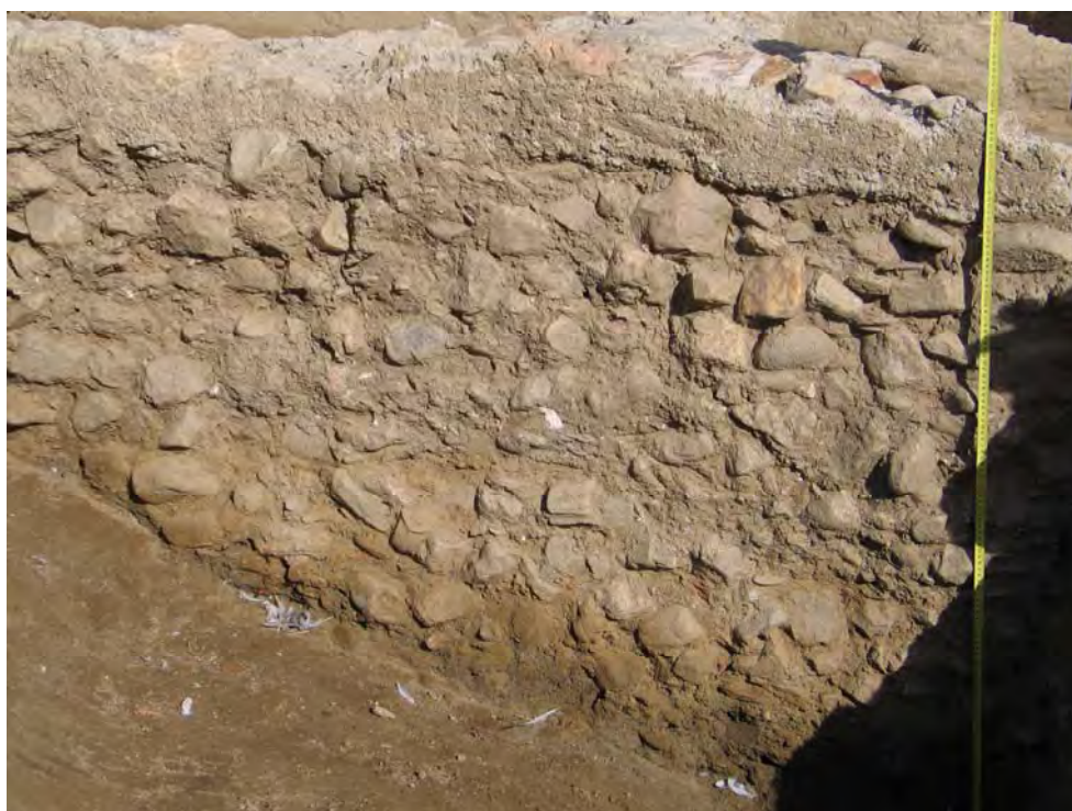
Figura 24: Cimentación B, en el que sólo se han usado cantos rodados de cuarcita.
