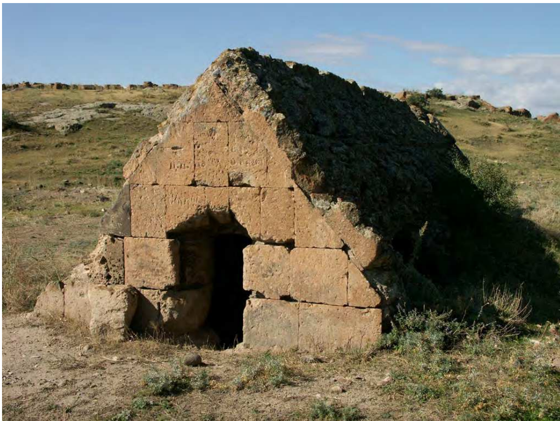
Fig. 9 – Construction voûtée au nord-est de la basilique (citerne ? mausolée ?) Cliché de P. Donabédian, CNRS-LA3M/UMR 7298, 2011.
