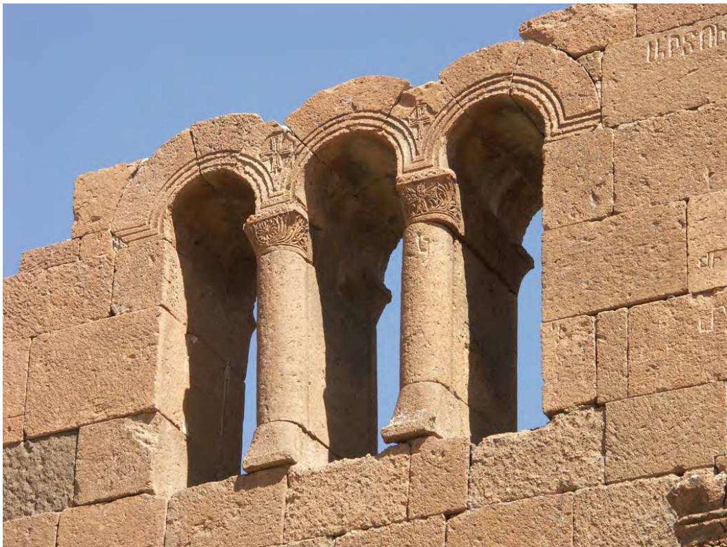
Fig. 163 – Façade ouest, fenêtre triple. Cliché de P. Donabédian, CNRS-LA3M/UMR 7298, 2013.
