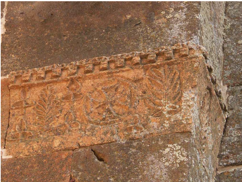
Fig. 155 – Galerie nord, abside, imposte sud, face nord. Cliché de P. Donabédian, CNRS-LA3M/UMR 7298, 2013.
