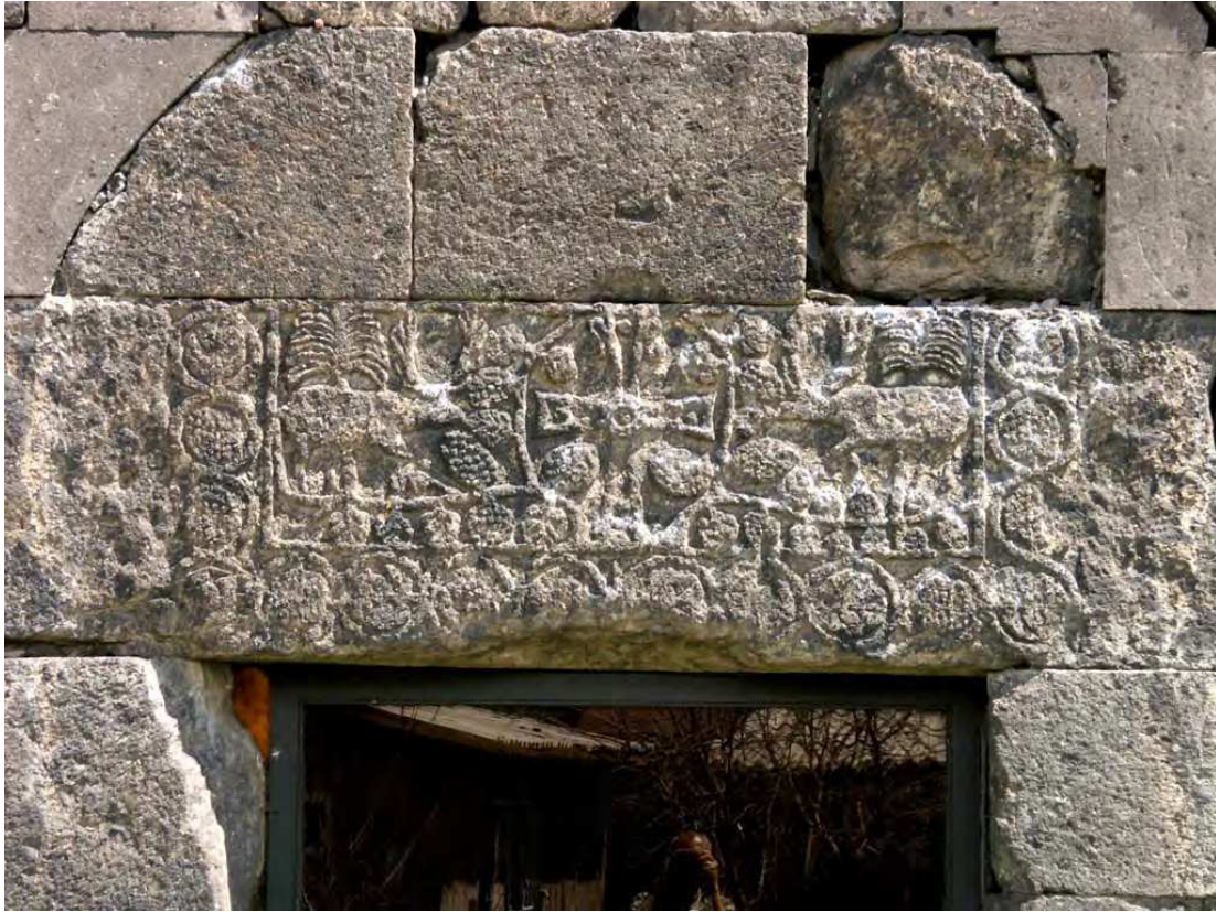
Fig. 142 – Basilique de Kassagh, linteau de la porte ouest. Cliché de P. Donabédian, 2006.
