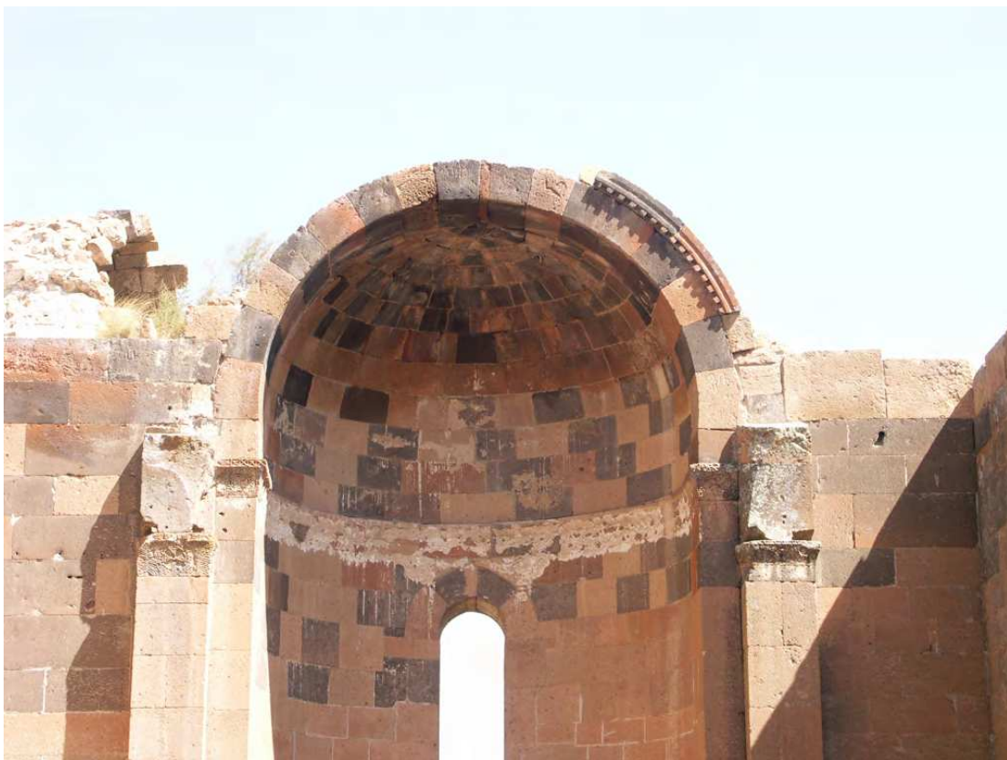
Fig. 109 – Voûte en cul-de-four du chœur de la basilique, depuis l'ouest. Cliché de P. Donabédian, CNRS-LA3M/UMR 7298, 2013.
