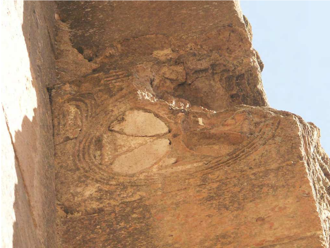
Fig. 150 – Pilastre au nord de l'abside principale, face nord. Cliché de P. Donabédian, CNRS-LA3M/UMR 7298, 2013.
