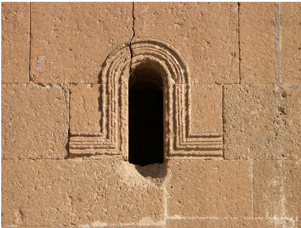
Fig. 128 – Façade sud, fenêtre de la sacristie sud-est. Cliché de P. Donabédian, CNRS-LA3M/UMR 7298, 2013.
