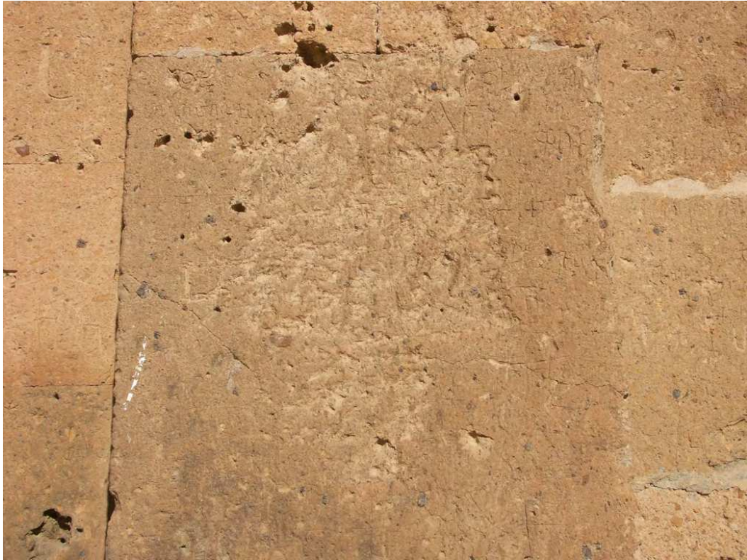
Fig. 118 – Face ouest du pilastre contre la sacristie sud-est de la basilique. Cliché de P. Donabédian, CNRS-LA3M/UMR 7298, 2013.
