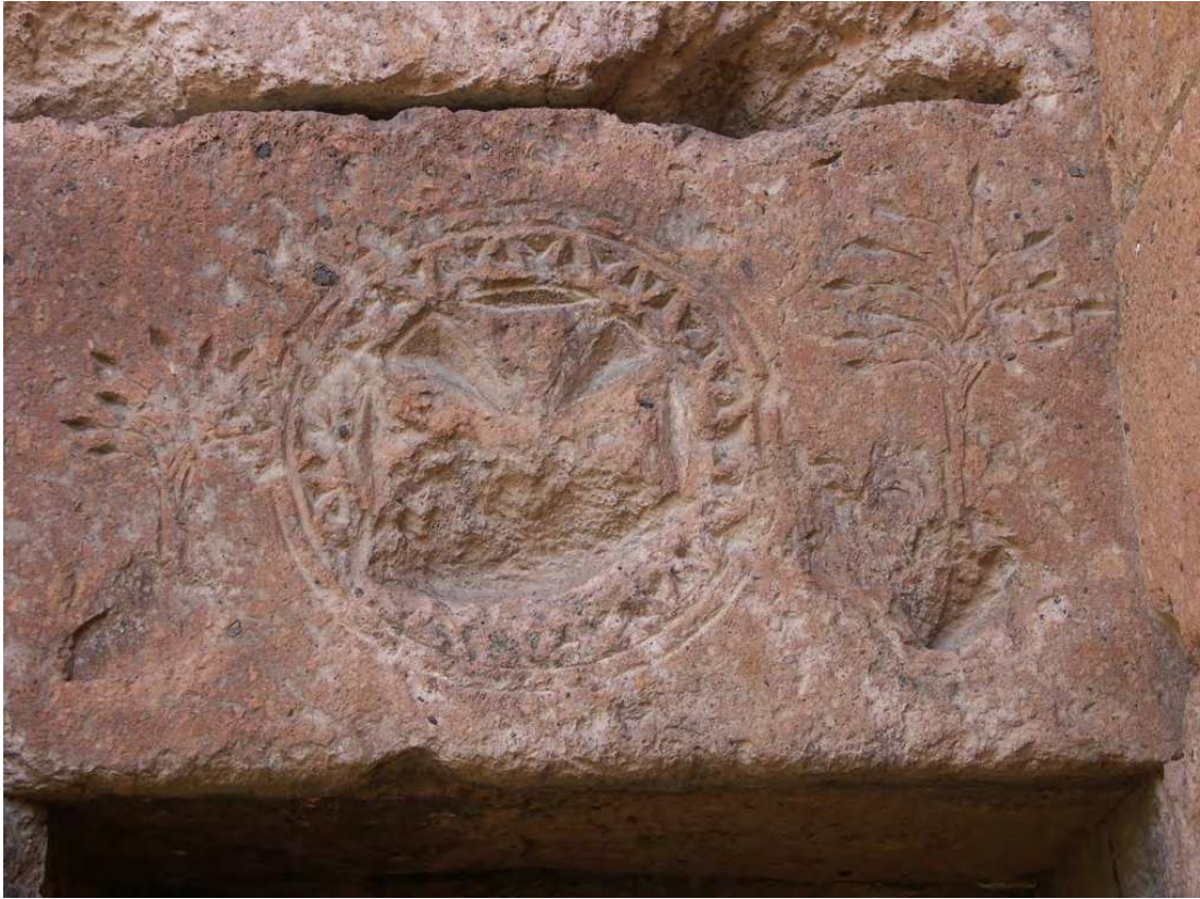
Fig. 136 – Linteau de la porte de la sacristie sud-est. Cliché de P. Donabédian, CNRS-LA3M/UMR 7298, 2013.
