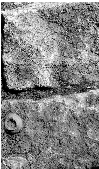
Fig. 10. Blocs de Calcaire à entroques dans le seuil ouest de la maison de la ferme 1 (cliché P. Beck).
