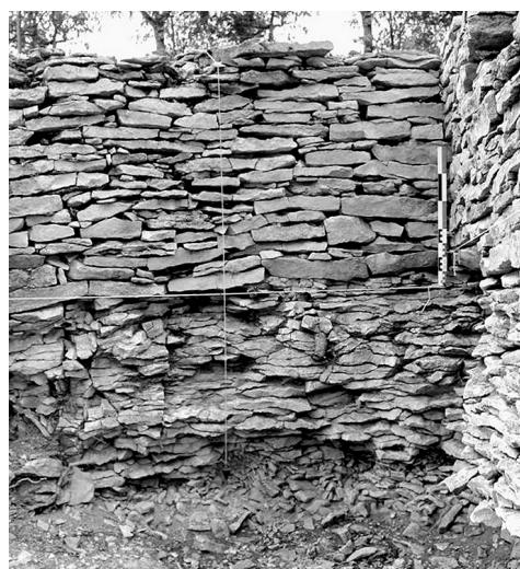
Fig. 5. Parement interne du mur nord du bâtiment d'habitation de la ferme 2, élevé à l'aplomb de la roche excavée sur 0,70m de profondeur (Cliché P. Beck).
