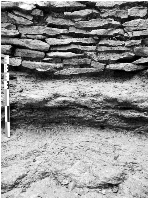
Fig. 9. Cuvelage du Puits Gaillard habillant l'horizon marneux et reposant sur les parois du creusement de la pierre de Dijon-Corton inférieure (cliché P. Beck).
