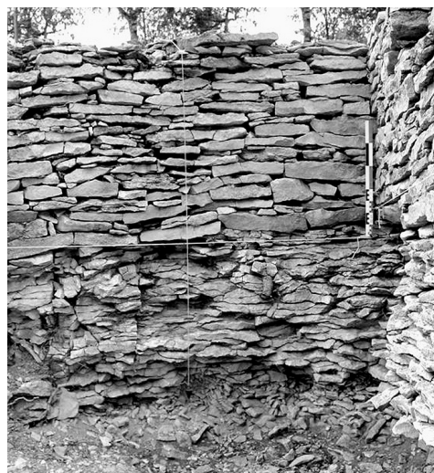
Fig. 5. Parement interne du mur nord du bâtiment d'habitation de la ferme 2, élevé à l'aplomb de la roche excavée sur 0,70m de profondeur (Cliché P. Beck).
