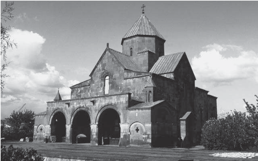
Fig. 30 Vałaršapat, Surb Gayianē. Vue générale sud-ouest.
