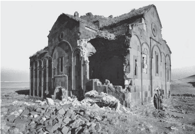
Fig. 34 Ani, cathédrale. Vue générale nord-ouest après le séisme de 1988. Photo R. et B. Elbrecht (1991).
