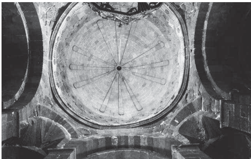
Fig. 18 Vaĥaršapat, Surb Hrip'simē. Intérieur, vue zénithale.
