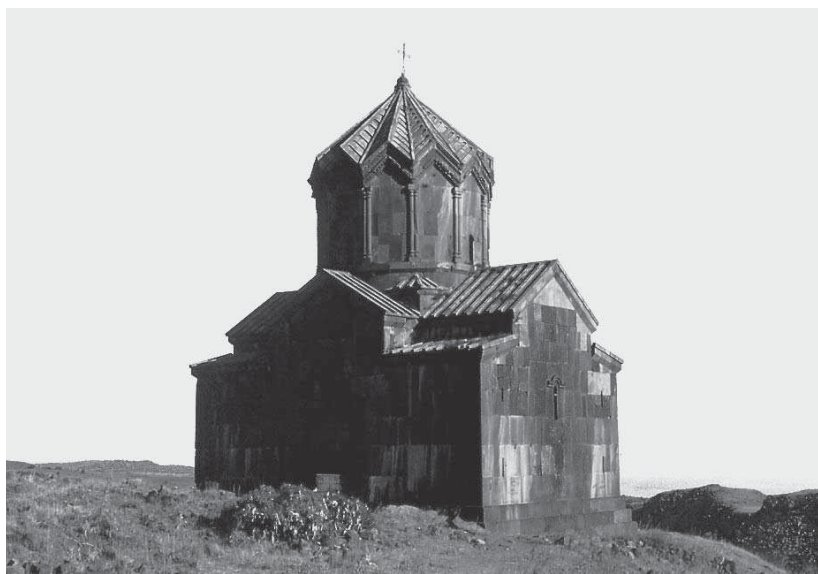
Fig. 43 Amberd, église du fort (1026). Vue générale Nord-Ouest.
