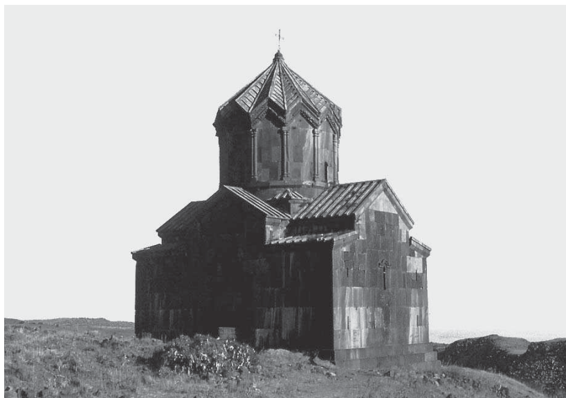
Fig. 43 Amberd, église du fort (1026). Vue générale Nord-Ouest.
