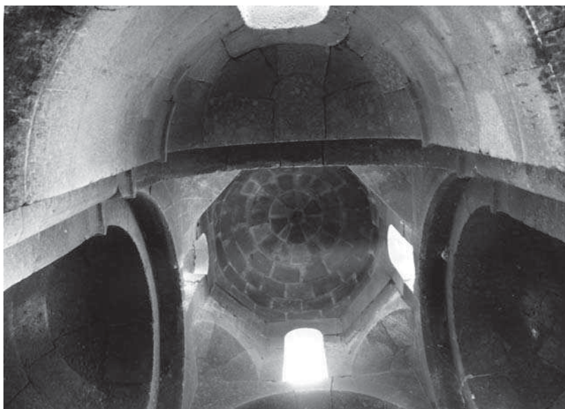
Fig. 22 Õšakan, Surb Mankanoc'. Intérieur, vue zénithale.
