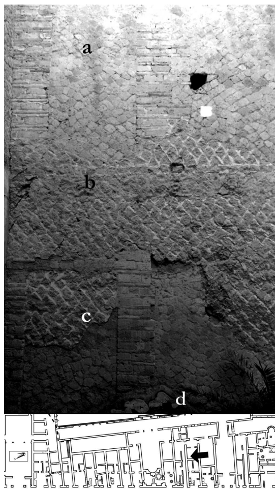
Fig. 6. Paroi septentrionale de la pièce A. On notera que sous la fenêtre (a), aucune solive ne soutient le plancher en (b). En bas, le montant oriental de la porte (c) est recouvert d'un enduit (d) correspondant à la première décoration de III e style, indice de révision du projet initial.
