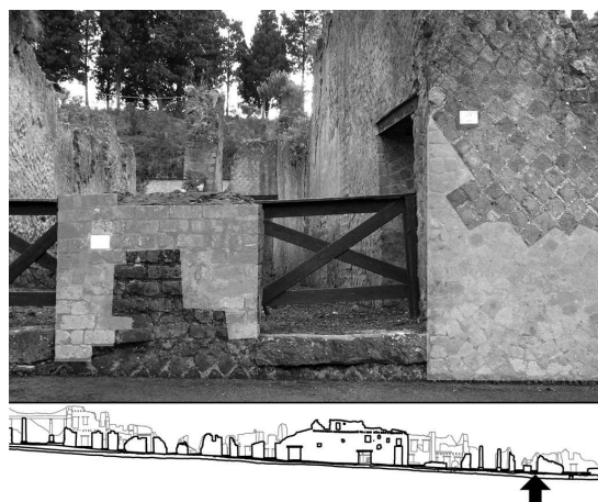
Fig. 11. Façade de l'entrée Or. II, 2. Si l'on écarte les restaurations modernes (en grisé), on en conclut que le montant droit a été taillé après la construction initiale pour percer cette porte.
