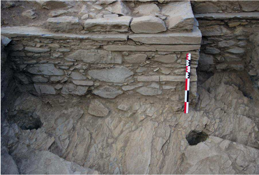
Phot. 28 – Secteur 2, bâtiment B2 : élévation extérieure du mur nord-ouest (M 2012), avec son assise de dalles de schistes en léger ressaut (phot. J. Charbonnier, 2012).
