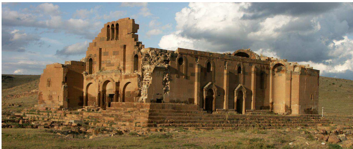
Fig. 16. Ereroyk', basilique, vue extérieure (sud-ouest).
