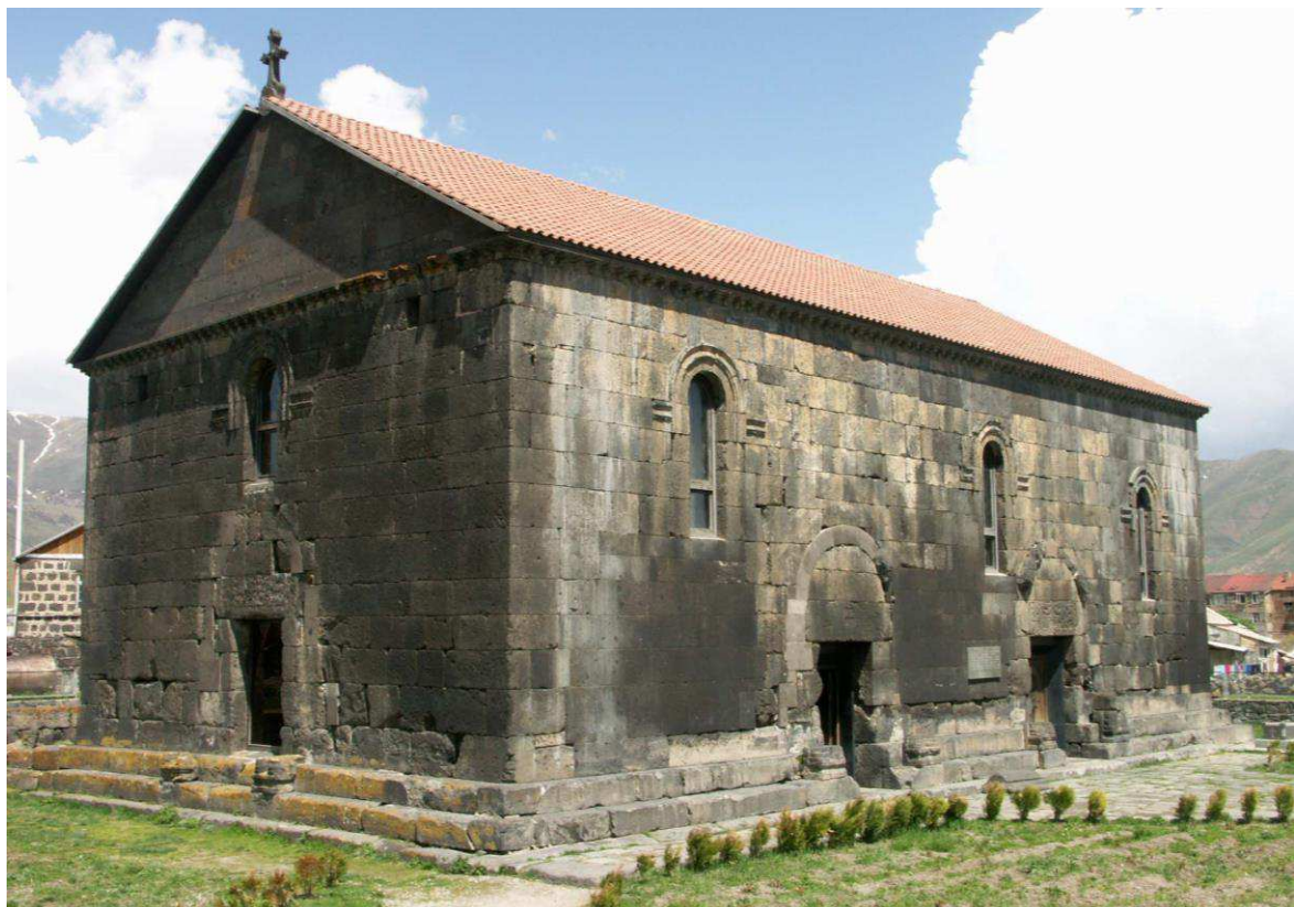
Fig. 14. K'asał, basilique Sainte-Croix, vue extérieure (sud-ouest).
