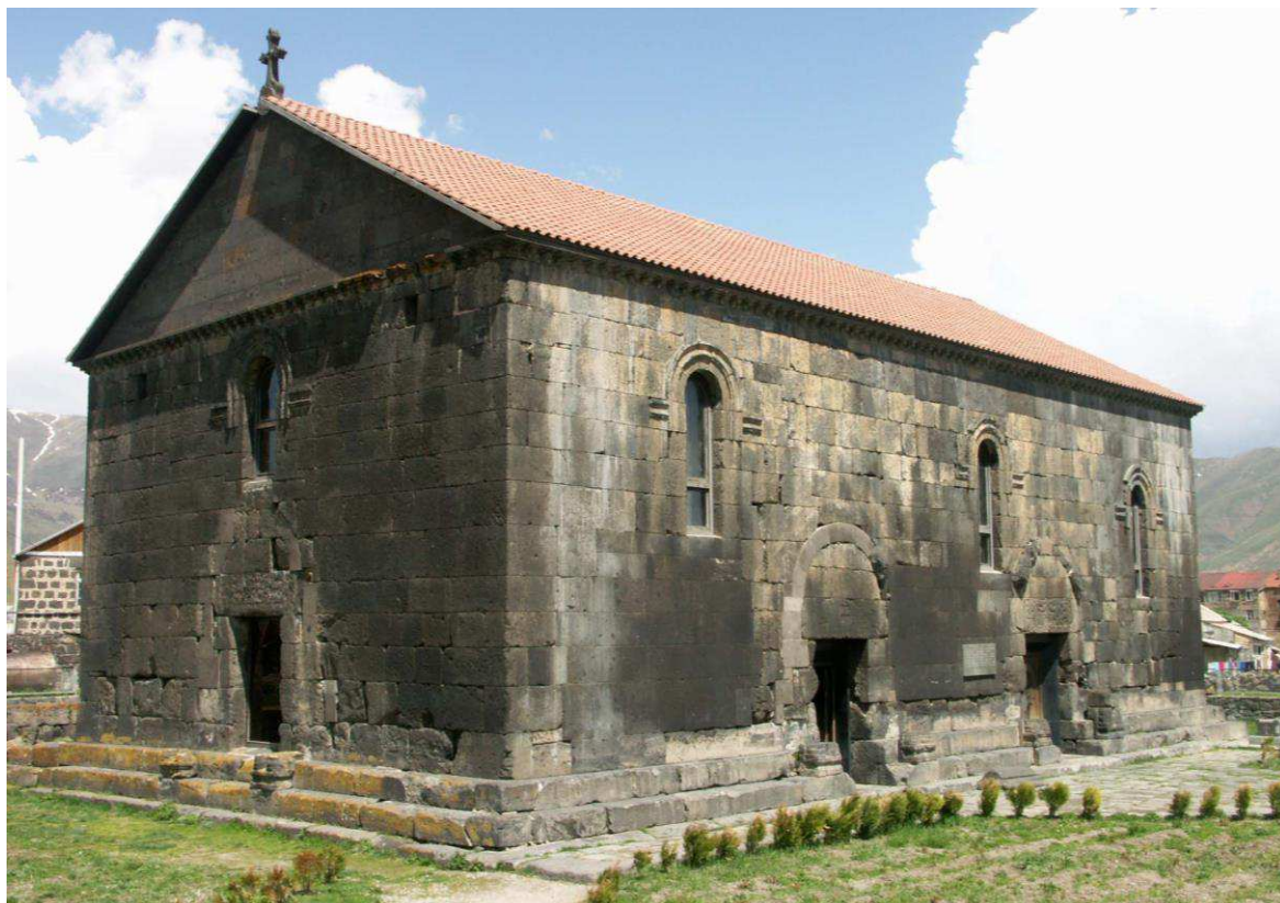
Fig. 14. K'asał, basilique Sainte-Croix, vue extérieure (sud-ouest).
