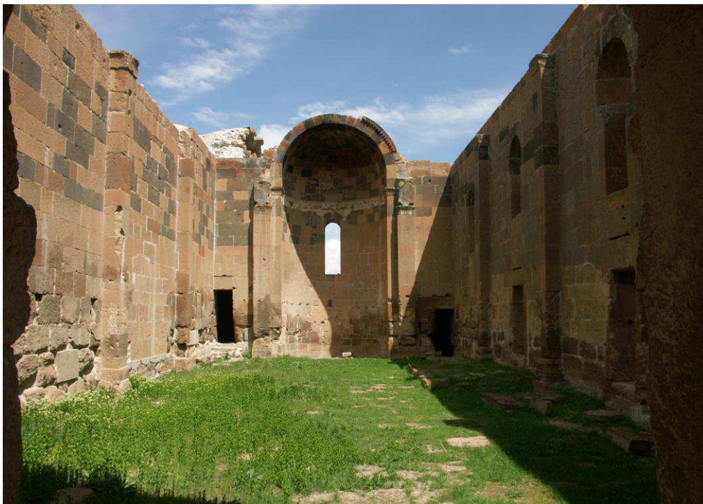
Fig. 17. Ereroyk', basilique, vue intérieure générale vers l'abside.
