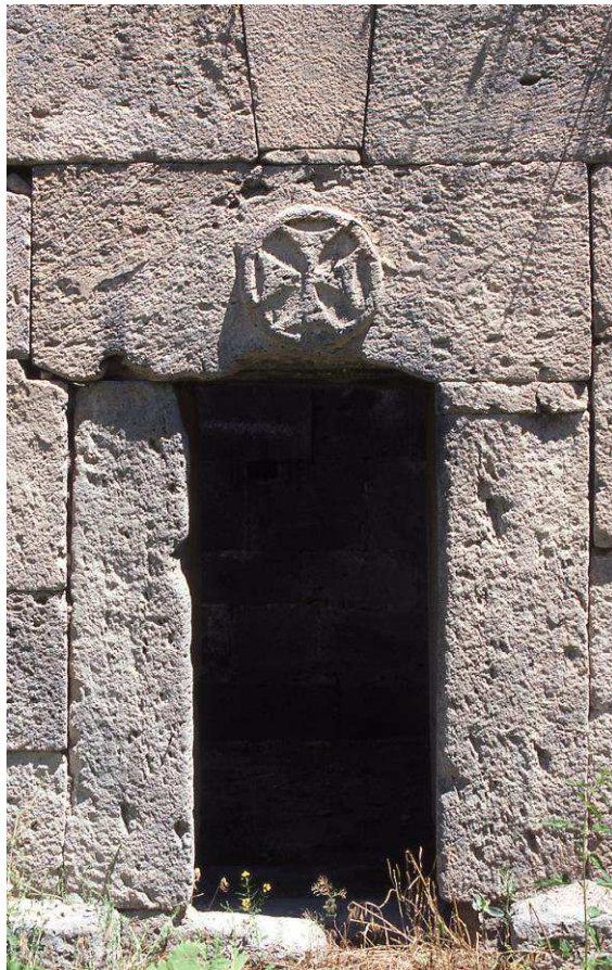
Fig. 22. Bayburt, chapelle, vue de la façade sud.
