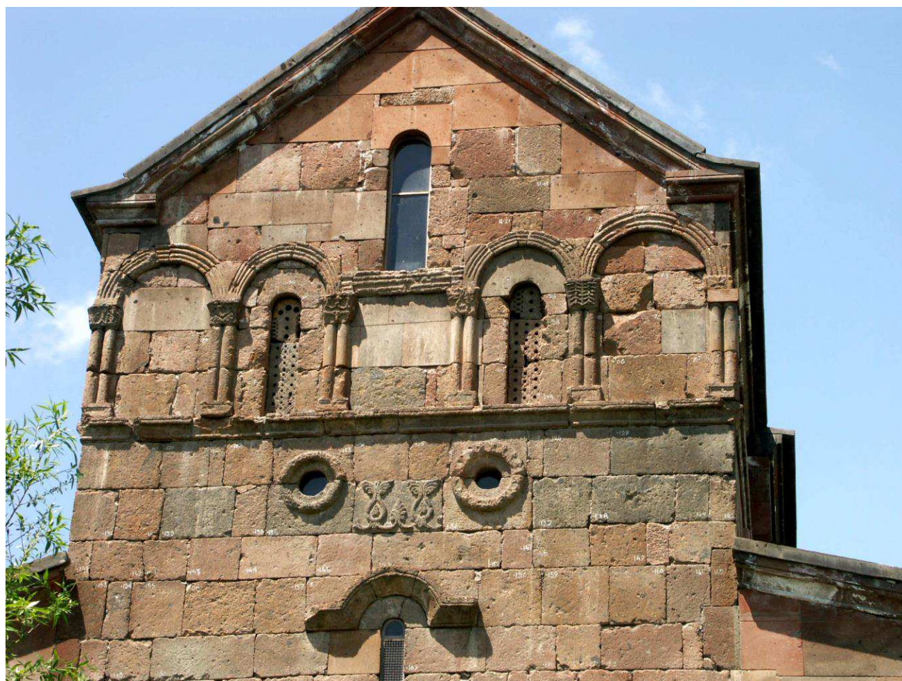
Fig. 12. Biwrakan, église Saint-Jean, détail de la façade est.
