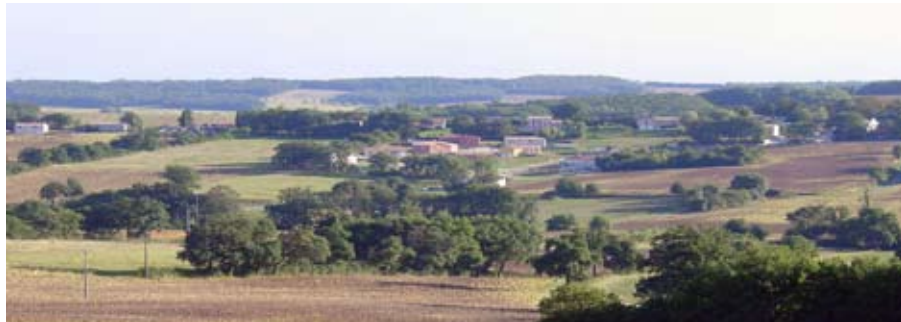
Deux implantations types de l'habitat résidentiel : en ligne de crête et sous la forme de petit lotissement
