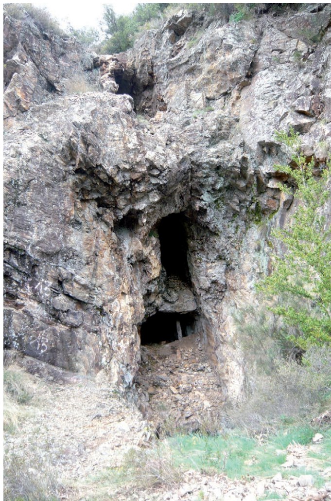
Fig. 1 Filon de la Rouvière : vieux travaux conservés au-dessus des chantiers modernes (cl. GEMA).
