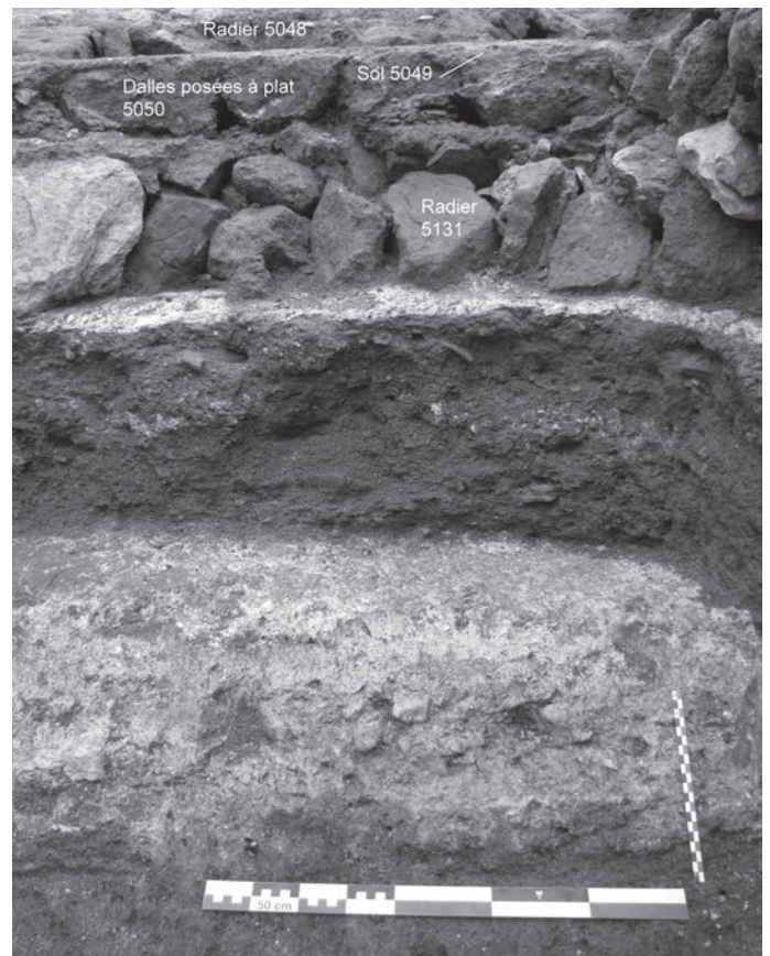
Fig. 55 – Espace 5 : détail de la succession de deux solides radiers de fondation (cliché et DAO : Y. Labaune, SAVA).
