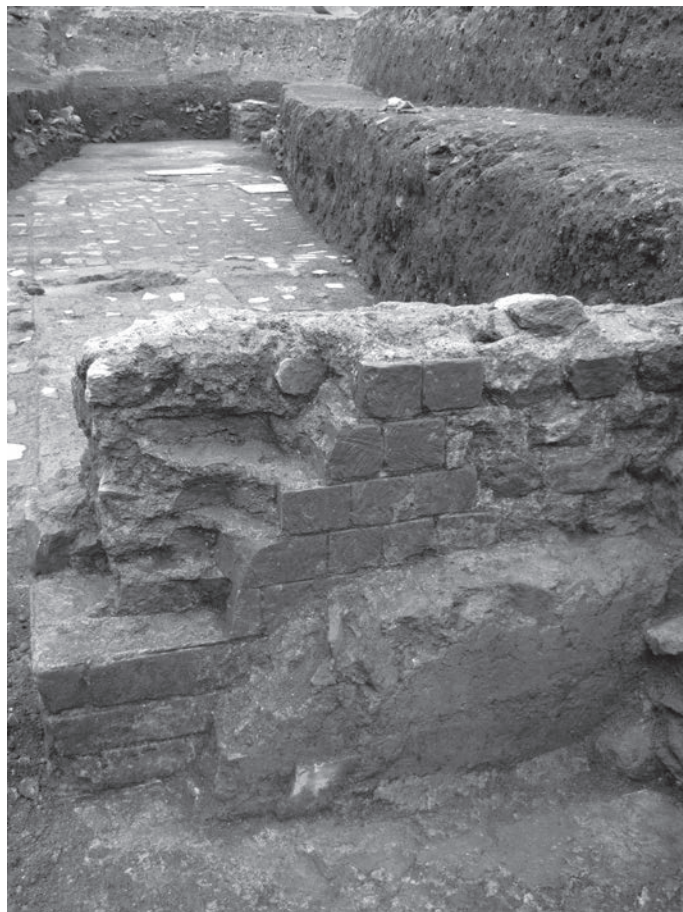
Fig. 48 – Vue prise du nord-ouest du parement oriental du mur M3, recouvert d'une couche d'enduit de tuileau d'une épaisseur importante ; en arrière-plan l'espace 1 (cliché : Y. Labaune, SAVA).
