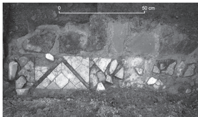
Fig. 6 – Pavement en opus sectile sur hypocauste, habitat de l'îlot IX-X9 (cliché : Y. Labaune, SAVA).
