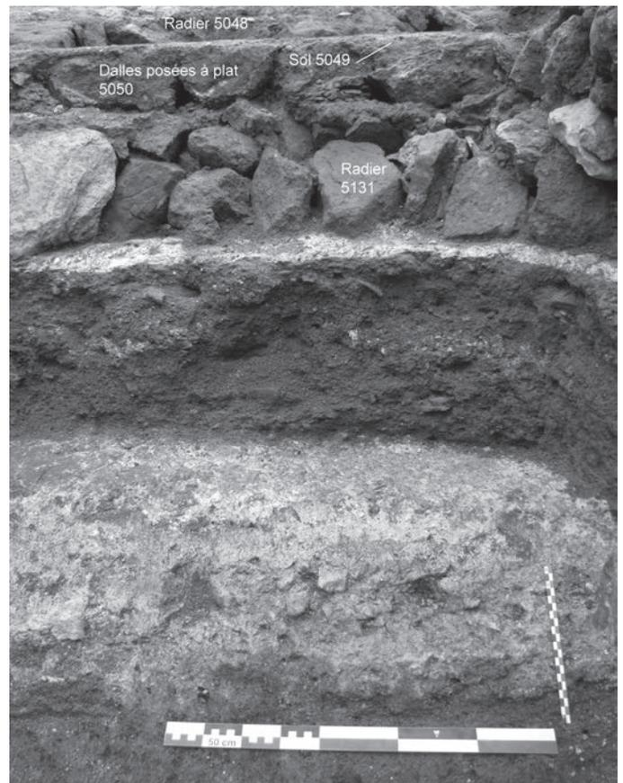
**Fig. 55** – Espace 5 : détail de la succession de deux solides radiers de fondation (cliché et DAO : Y. Labaune, SAVA).
