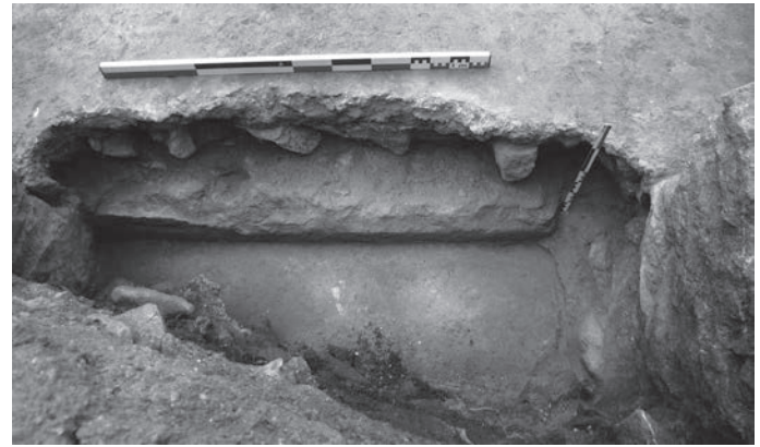
Fig. 54 – Espace 1 : succession de deux sols de circulation en mortier de tuileau construits sur radier (cliché : Y. Labaune, SAVA).
