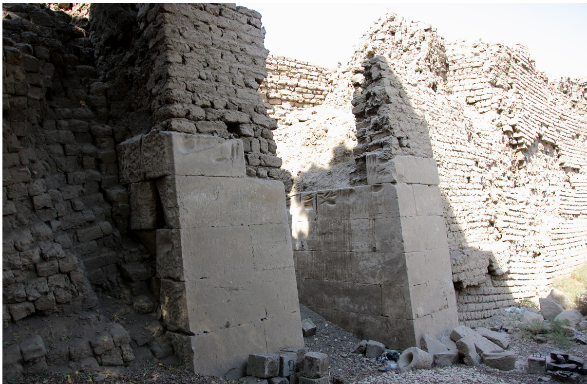
Fig. 2. Enceinte d'Amon, portion ouest : porte à l'extrémité nord © Cnrs-Cfeetk/P. Zignani.
