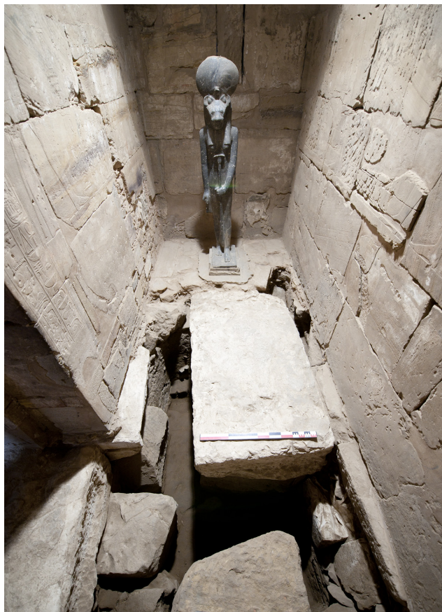
Fig. 16. Chapelle d'Hathor, dalle de couverture en calcaire réutilisée en sol © Cnrs-Cfeetk/J.-Fr. Gout.
