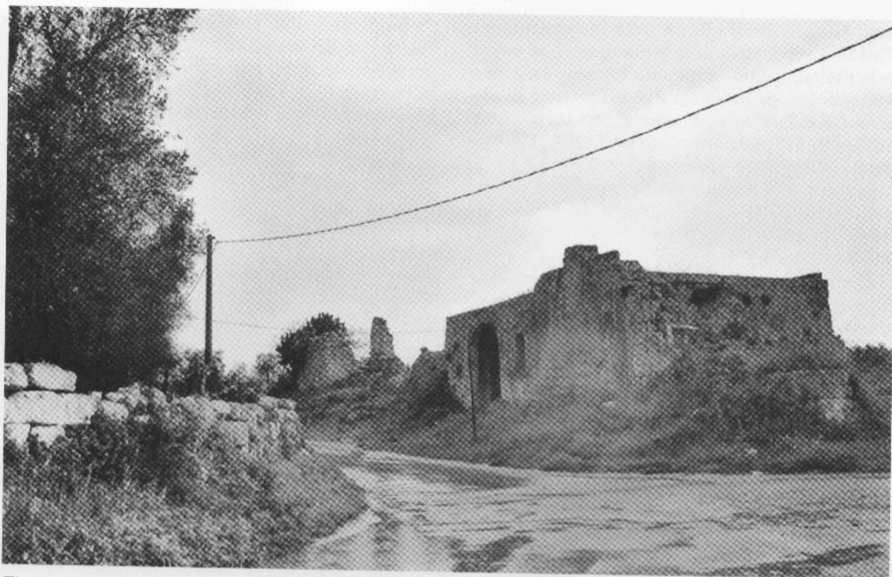
Fig. 28. Edifici rurali abbandonati in località Palanzano (G.S.)
