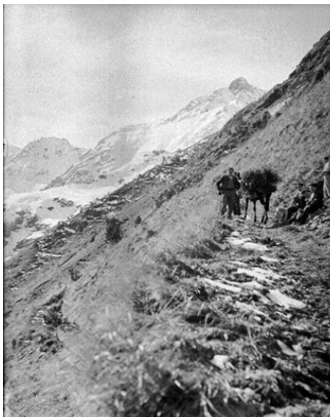
Figure 4. Boisement de Laou d'Esbas (Haut Comminges). Transport à dos de mule des plants forestiers sur le chantier (source CNRS : photo n° 2047, BD Gaussen 1936).
